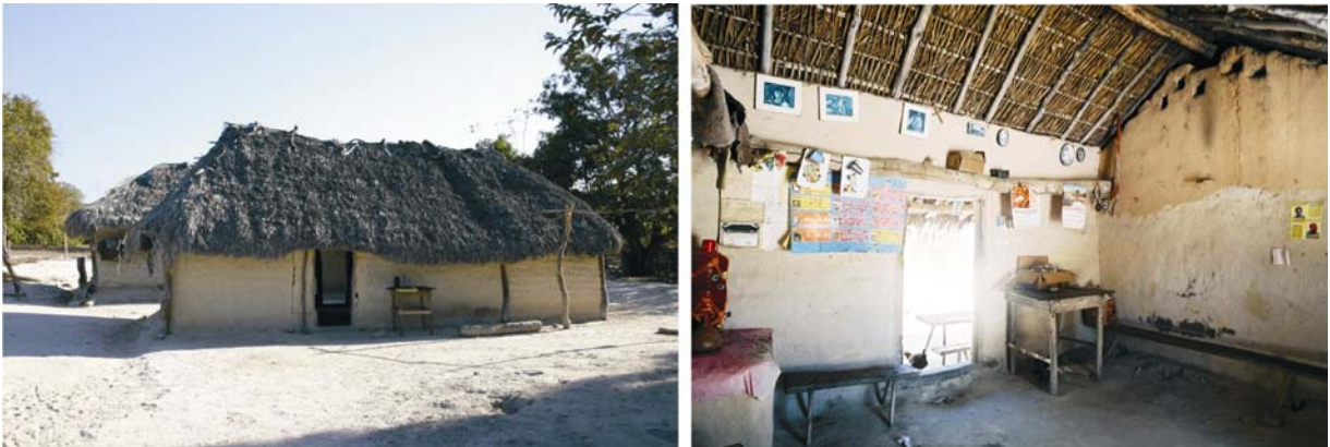
Figuras 3 e 4 – Exemplo de arquitetura vernacular: moradia feita em tijolos de adobe com cobertura em madeira roliça e palha, retiradas do local.
