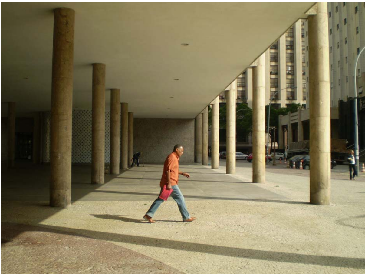
Figura 54 – Pilotis do Palácio. Fonte – Fotografarte 2008.
