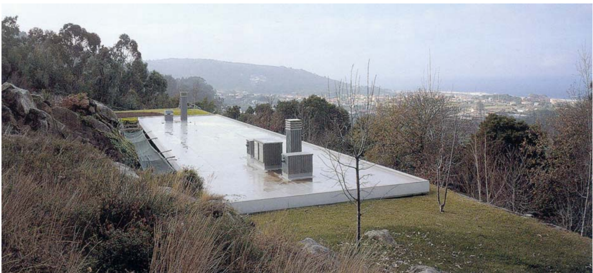
Figura 33 – Casa em Moledo. Parte superior da residência. Fonte – El Croquis . Madri, n. 124, 2005.
