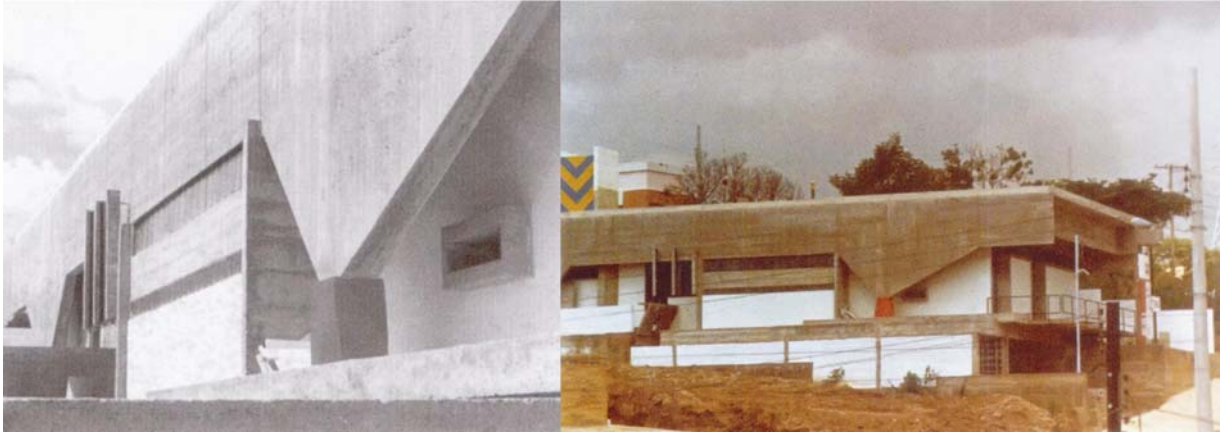
Figuras 55 e 56 – Residência Marcos Tadeu.
