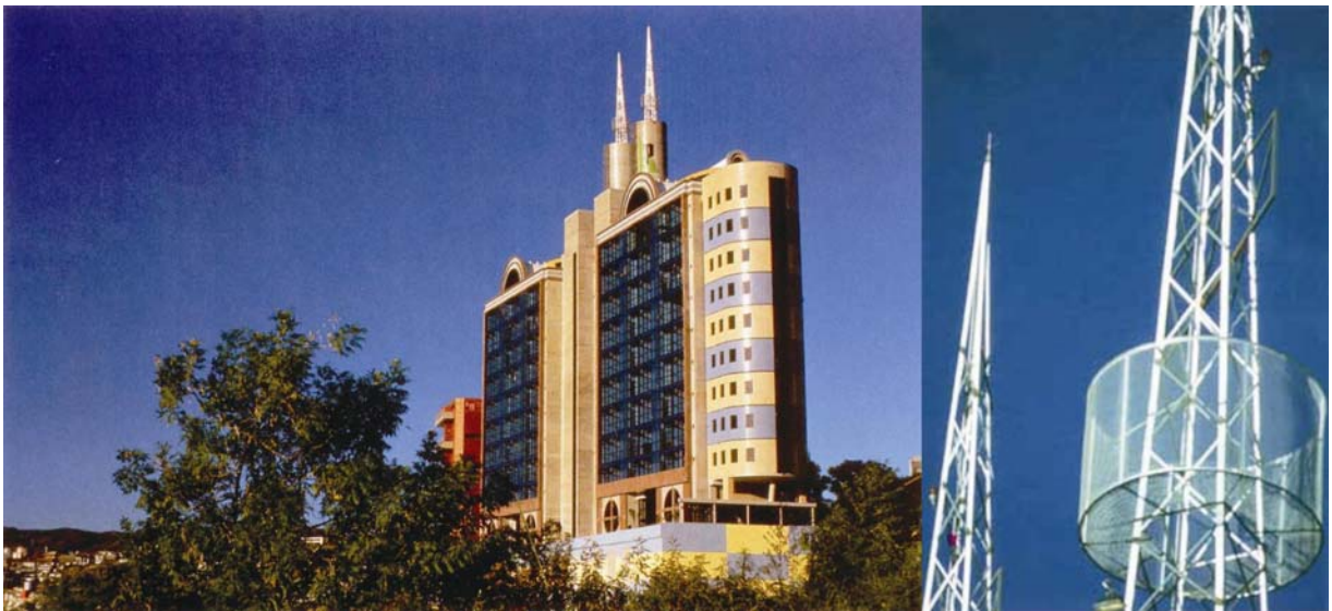
Figuras 59 e 60 – Centro Empresarial Raja Gabaglia: perspectiva do edifício e detalhe das torres. Fonte – Fig. 59: CECÍLIA, Bruno. Éolo Maia – Complexidade e Contradição na Arquitetura Brasileira . Belo Horizonte: Editora UFMG, 2006; fig. 60: < www.eolojo.com.br >
