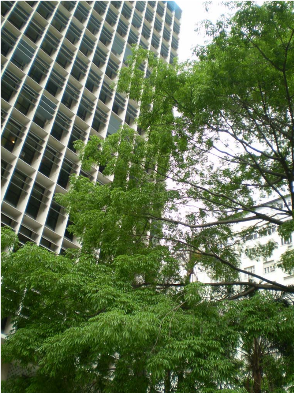
Figura 48 – Palácio Gustavo Capanema. Fonte – Mostra Fotografarte 2008.
