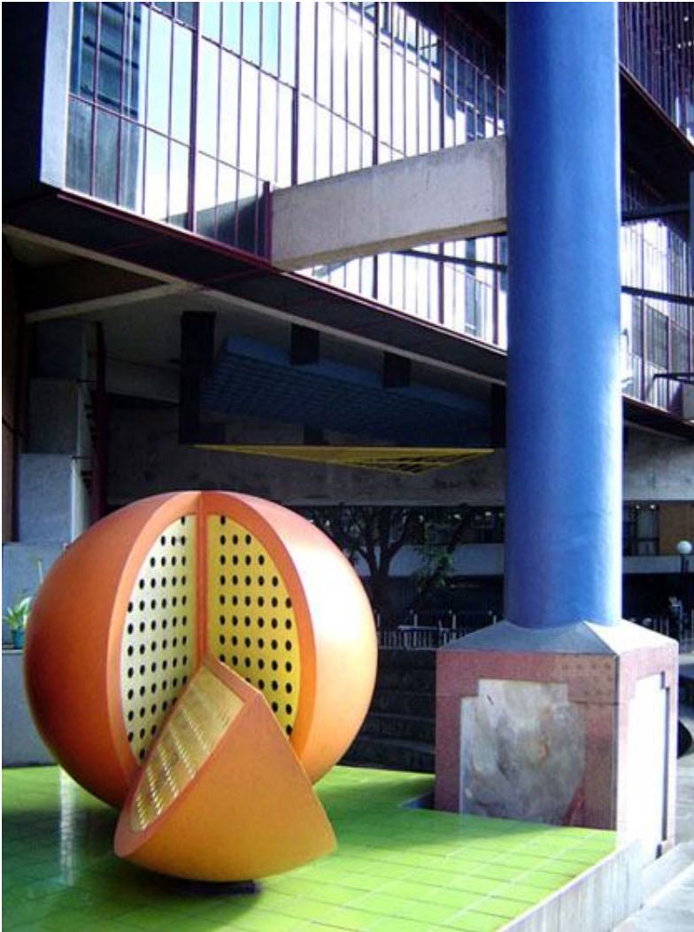
Figura 72 – Detalhe da ventilação do subsolo. Fonte - < www.mcb.sp.gov.br >
