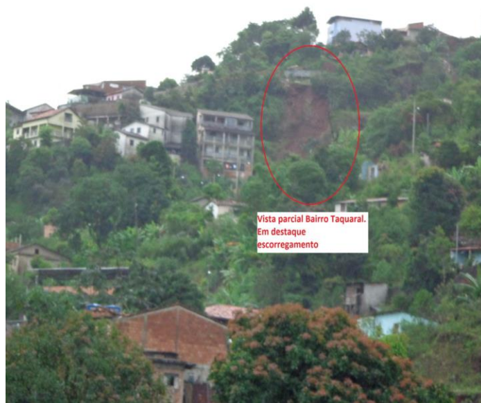
Foto 11: escorregamento no Bairro Taquaral. Fonte: foto da autora. Jan/2013
