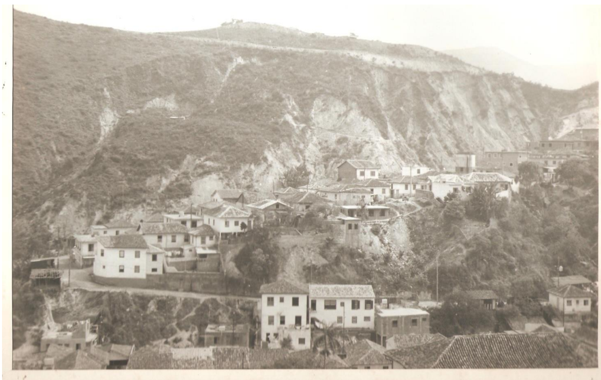
Foto 1: Escorregamento no Bairro São José - Ouro Preto em 1979. Fonte: Relatório tecnosolo/Arquivos IPHAN Ouro Preto
