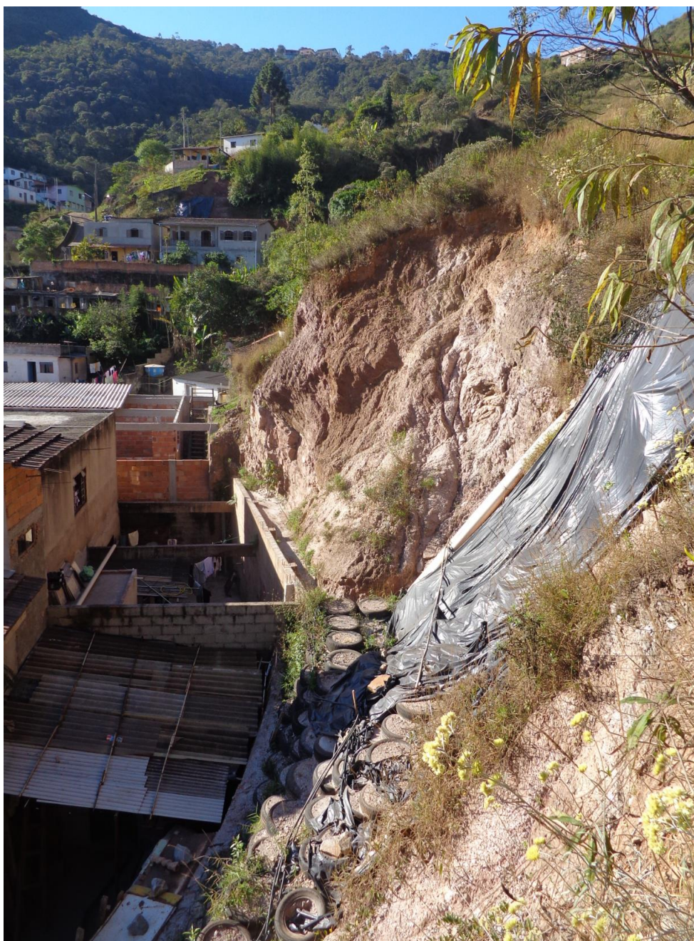
Foto 16: Medidas adotadas para evitar deslizamento por parte dos moradores. Local: Morro do Piolho. Fonte: foto da autora. Jan/2013
