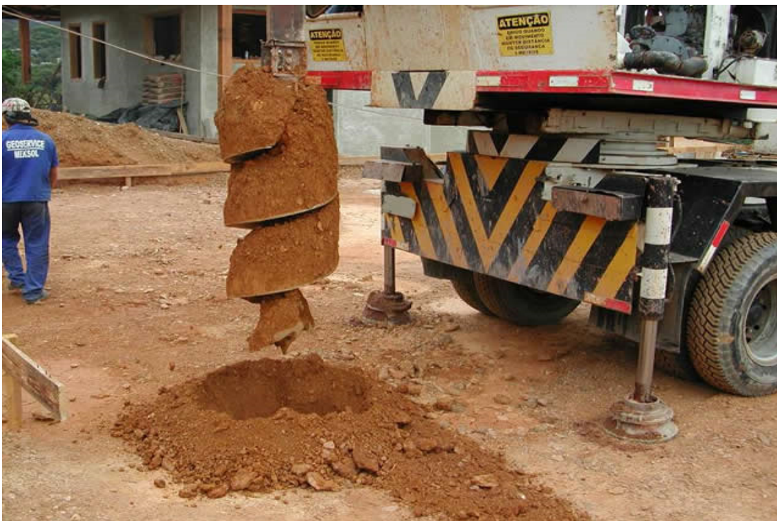
Figura 2.10. Equipamento para execução de estacas escavadas com trado mecânico. ( http://www.meksol.com.br/servicos - Acesso em: 01/02/2012).
