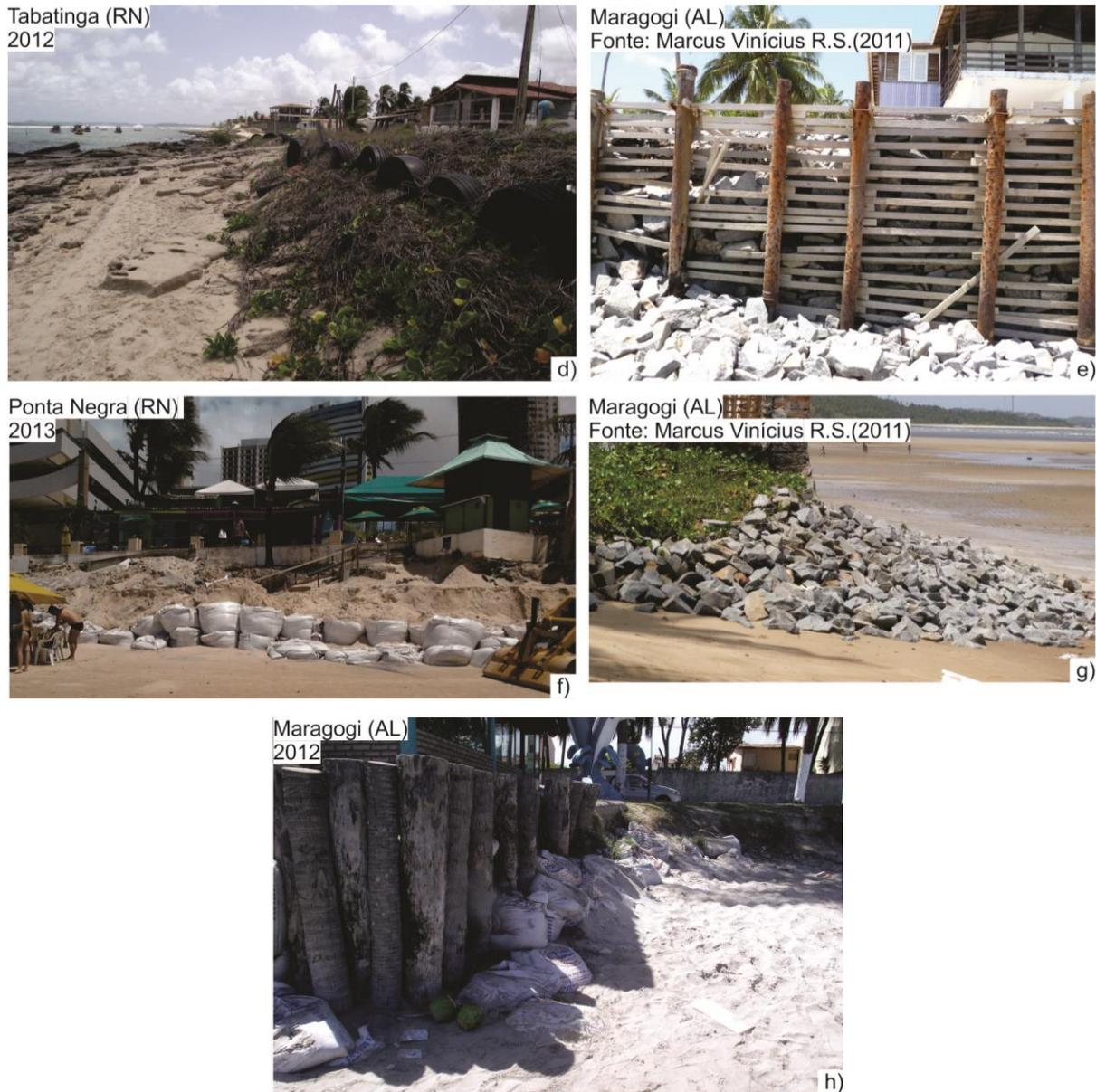
Figura 2.7 – Obras longitudinais aderentes à costa: a) engordamento artificial. Fonte: Notas de Aula TOLDO JR. citado por Oliveira (2012), b) muro de concreto em degraus, c) enrocamento com filtro geotêxtil, d) pneus, e) muro, f) sacos de areia, g) enrocamento, h) parede de troncos e sacos de areia.
