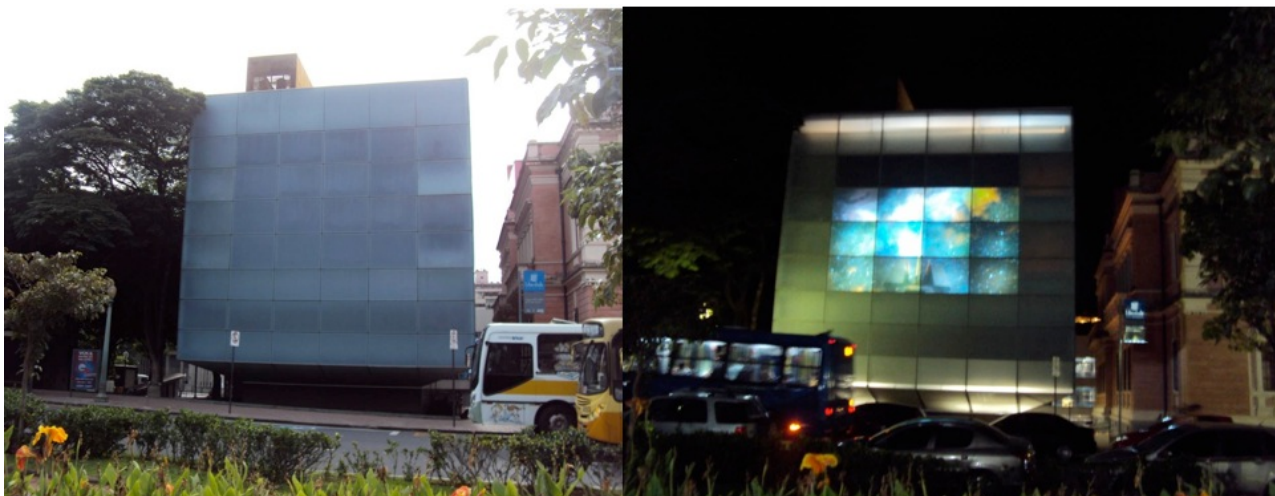
Edifício Espaço TIM UFMG, Belo Horizonte, MG.
