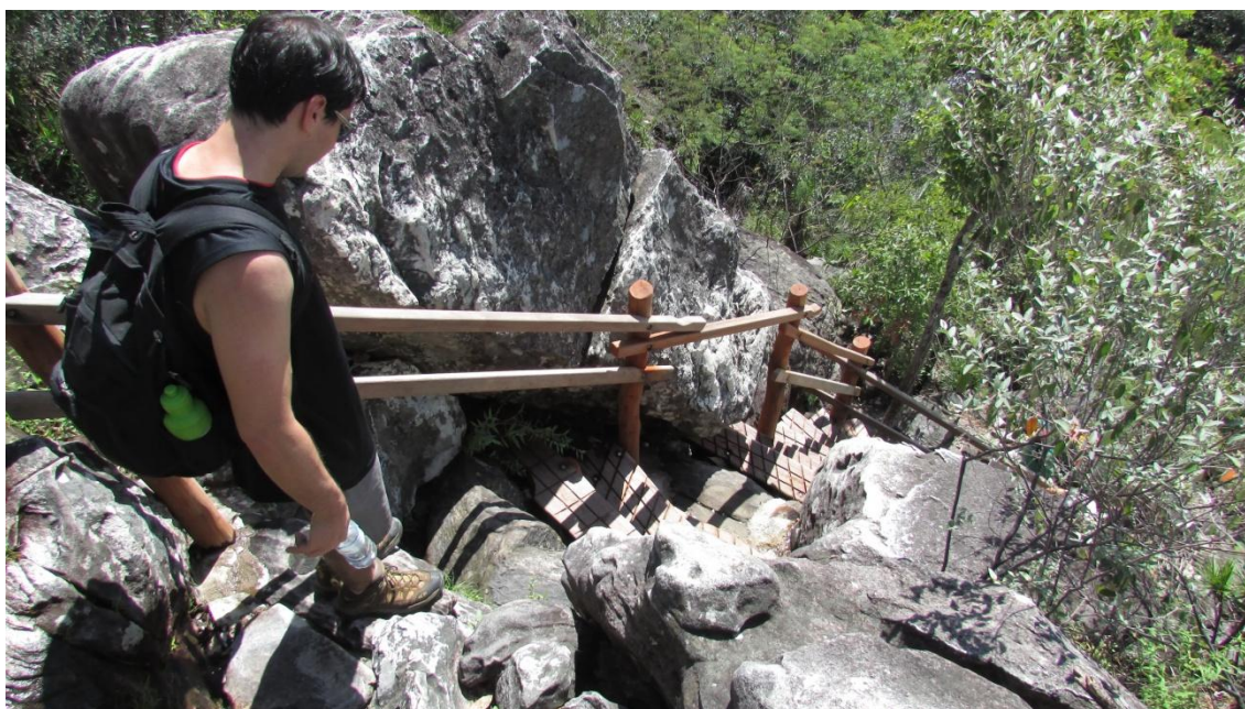
Figura 37: Escadaria de acesso à Carioquinhas
