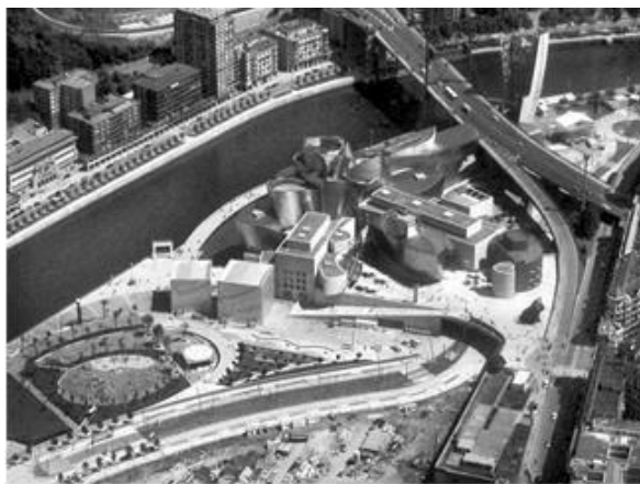
Figura 08: Vista aérea do Museu Guggenheim de Bilbao. Fonte: SILVA, 2007, p. 97.
