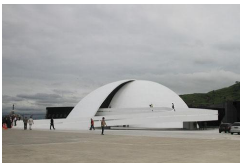
Figura 95: Fundação Oscar Niemeyer. Fonte: GONÇALVES, 2010, p. 29.
