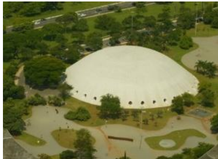
Figura 94: Vista aérea da Oca. Fonte: BOTEY, 1996, p.112.
