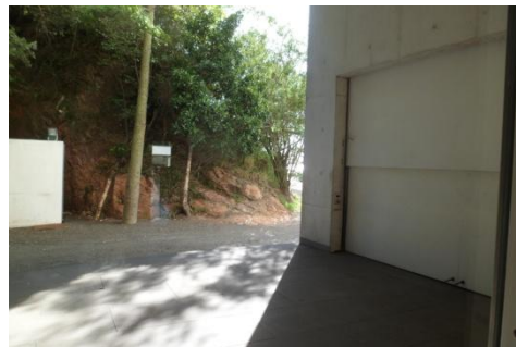
Figura 118: Acesso de serviço e elevador de obras. Fonte: Arquivo pessoal.
