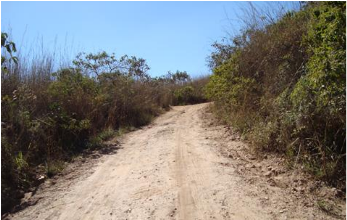
Foto: 81. Estrada de acesso na APP do reservatório, a forte declividade do terreno dificulta o acesso ao reservatório. Falta adequação ao PACUERA. Condomínio Lagoa Village, em Santo Antônio do Descoberto. Fonte: Castro. M.C. (2013).
