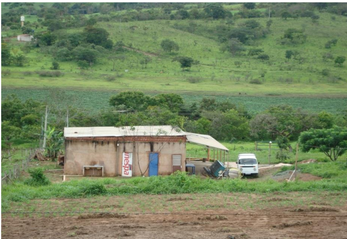
Foto: 50. Loteamento Point da Pesca, lindeiros à APP do reservatório. No braço do rio Descoberto. Note-se ao fundo, o verde escuro – cobertura do espelho d'água por macrófitas.
