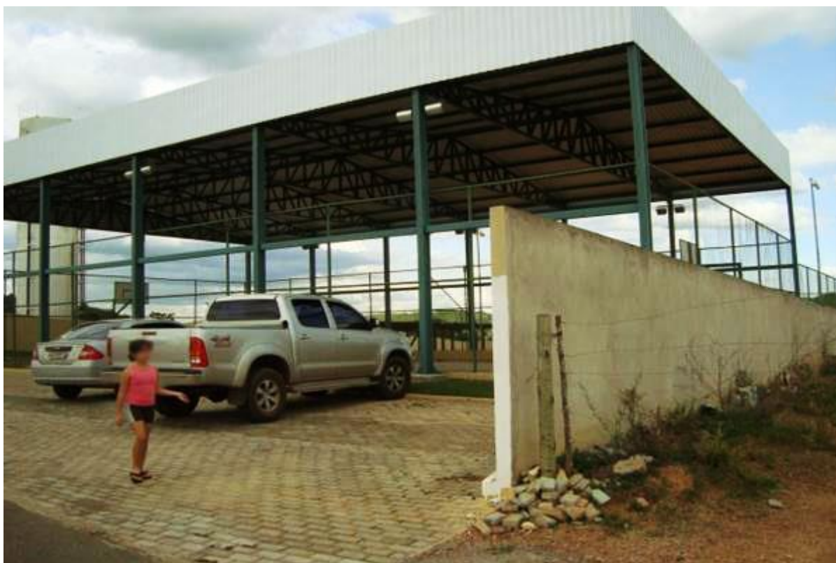
Foto: 14. Condomínio Real Ville, vizinho à APP de Corumbá IV, no município de Alexânia.
