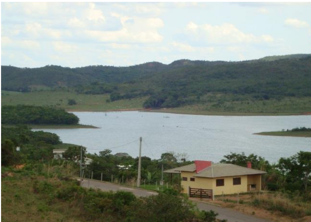
Foto: 13. Condomínio Real Ville. Relação de contiguidade condomínio e APP do reservatório Corumbá IV, no município de Alexânia.
