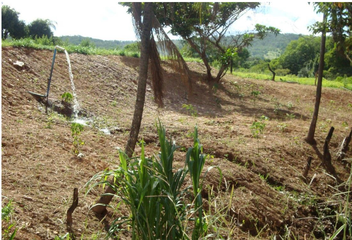
Foto: 86. A parte mais inclinada do terreno é o aterro do tanque de pescaria. Note-se a terra nua sem proteção. Note-se um cano que realiza a vazão do tanque, a água drenada já forma uma erosão no solo e carrega o material para o curso d'água à jusante. Fonte: Castro. M.C. (2014).
