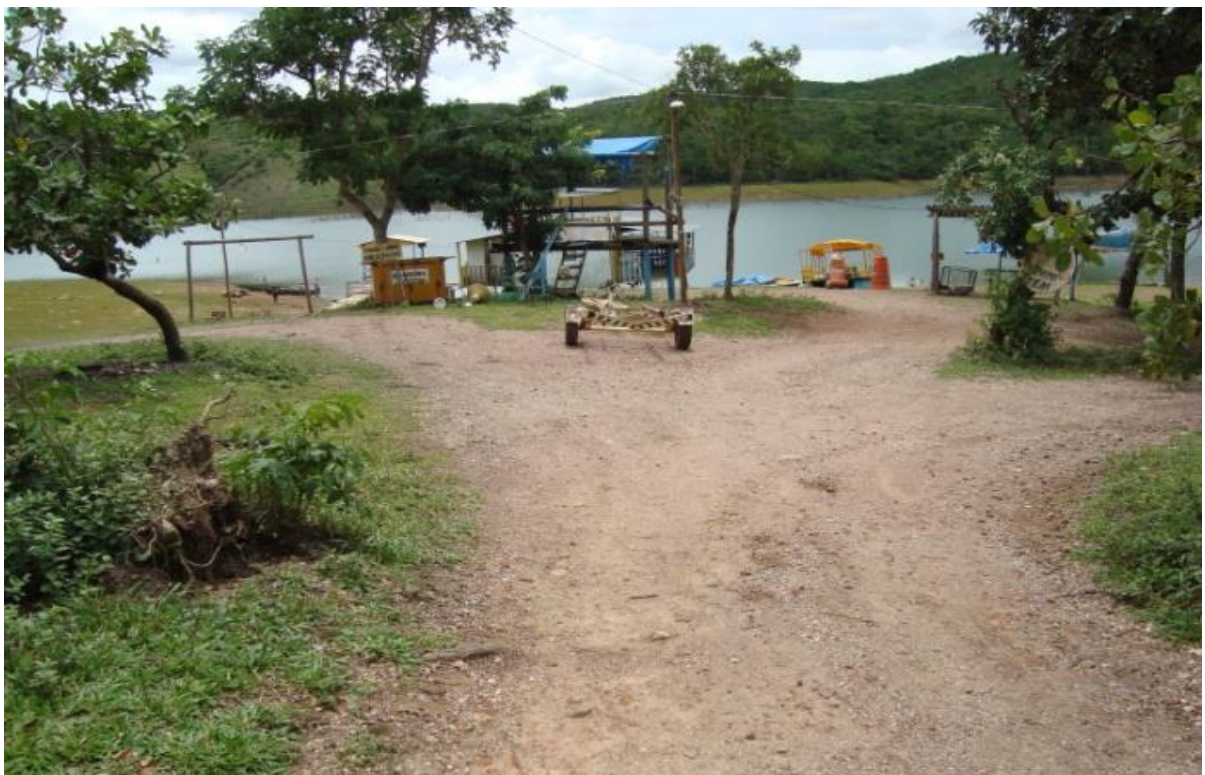
Foto: 79. Estradas de acesso ao reservatório criadas aleatoriamente. De repente, a estrada divide em três. Todas levam ao reservatório Corumbá IV. Note-se a quantidade de equipamentos montados na APP, sem nenhum critério.
