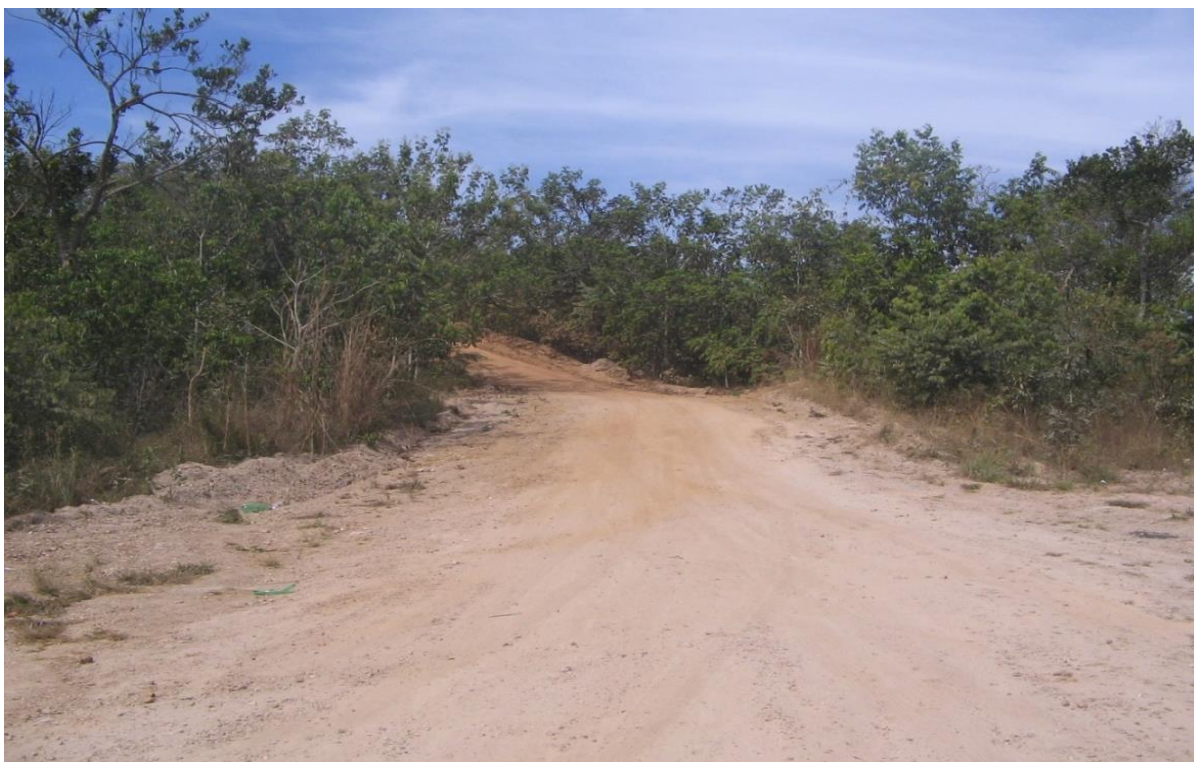
Foto: 87. Condomínio Recanto do Pescador. Estrada de acesso à APP e ao reservatório Corumbá IV. Infraestrutura improvisada sem calçamento. O condomínio fornece água por poço artesiano. A energia é precária e disponível apenas em alguns pontos. Fonte: Castro. M.C. (2013).
