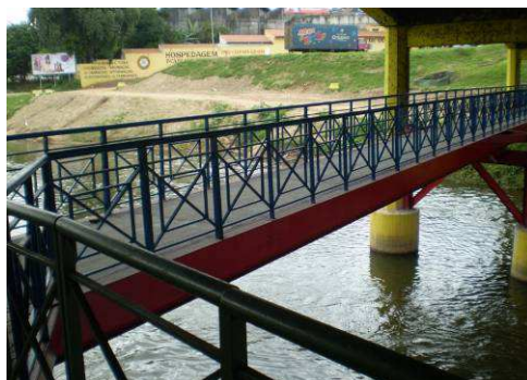
Figura 2.6: Ponte para Bicicletas em Sorocaba – “cicloponte”.
