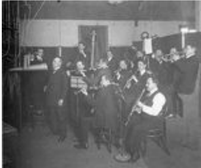
Figura 6. Foto de uma gravação na era acústica: organiza-se os músicos na sala para melhor resultado na gravação. O cantor está mais próximo da corneta. Metais ficam atrás e mais acima. Cordas, à frente dos sopros. Fonte: Welch e Burt (1994, p. 121).
