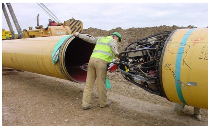
Figura 2.37 – Posicionamento do dispositivo para soldagem orbital interna (Fortes, 2004)
