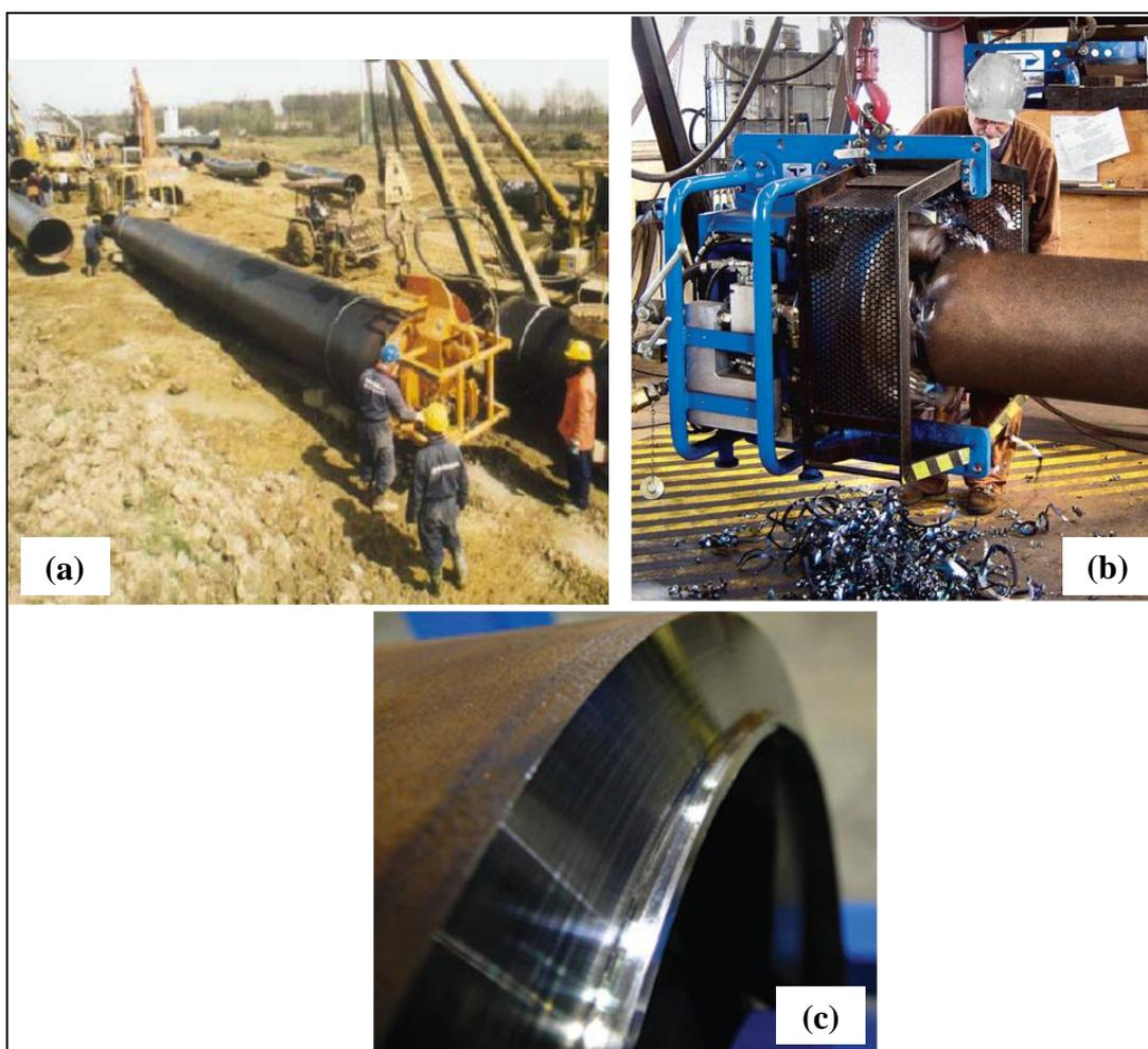
Figura 2.31 – Chanfradeiras em funcionamento em (a) campo (Fortes, 2004), (b) oficina e (c) aspecto final do chanfro no tubo (*Tri Tool INC.*, 2010)
