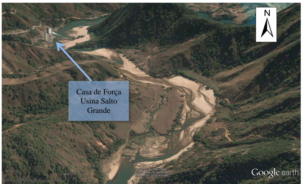
Figura 3.18. Vista em detalhe do Google Earth® na área da casa de força da Usina Salto Grande. Coordenadas: 23 K 740793.82 m E 7883867.59 m S. Fonte: Google Earth, acesso em 18/9/2013.
