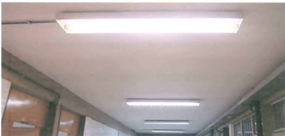
Figura 5.5: Corredor no departamento de Engenharia Florestal – Antes.
