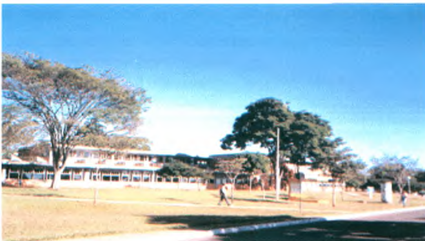
Figura 5.2: Vista externa do complexo da Faculdade de Tecnologia.
