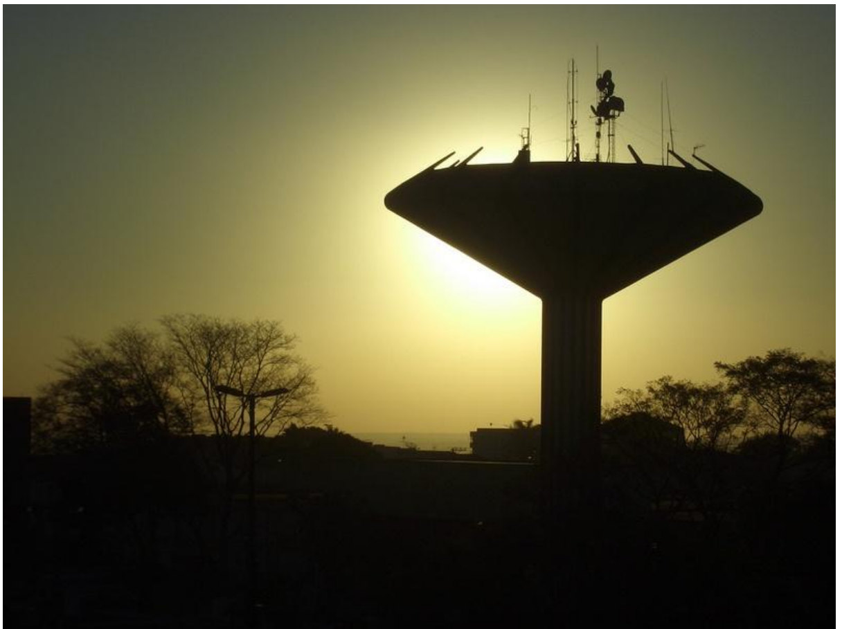
FIGURA 5 – Caixa D’agua (foto atual) localizada no centro da cidade Fonte: http://www.vitruvius.com.br/revistas/read/arquiteturismo/01.011-012/1393 )
