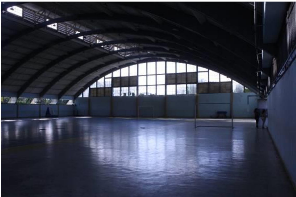
Figura 14: Vista interna do pavilhão de educação física – CECR. Fonte: Cleber Cardoso, 2011.
