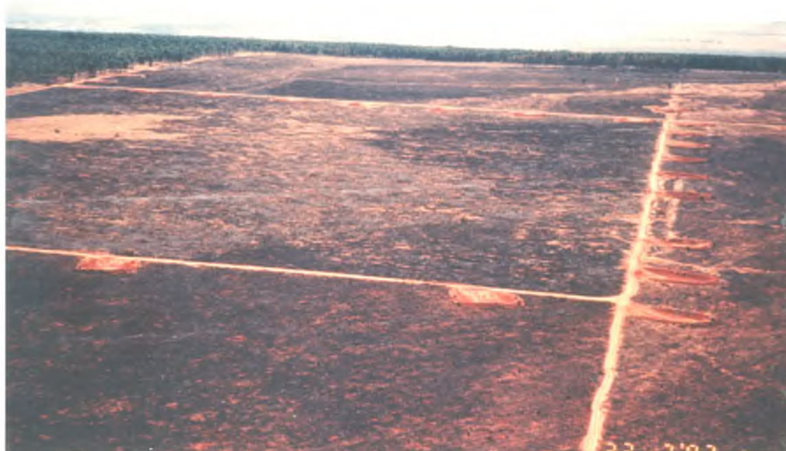
Foto 11 - Trabalho de contenção da energia de águas pluviais, para proteção do solo contra erosão. A EMATER tem desenvolvido trabalhos similares em outros locais da APA, principalmente, em núcleos rurais e margens de rodovias.
