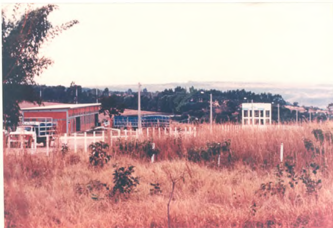
Foto 9 - Captação de água em poço profundo da empresa Indaiá, às margens da DF-250 entre vários condomínios
