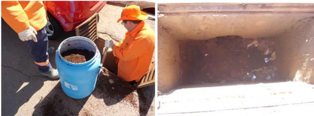
Figura 3. 9 - Funcionários ajudando na coleta dos resíduos (esquerda) e visão da boca de lobo UnB (direita)
