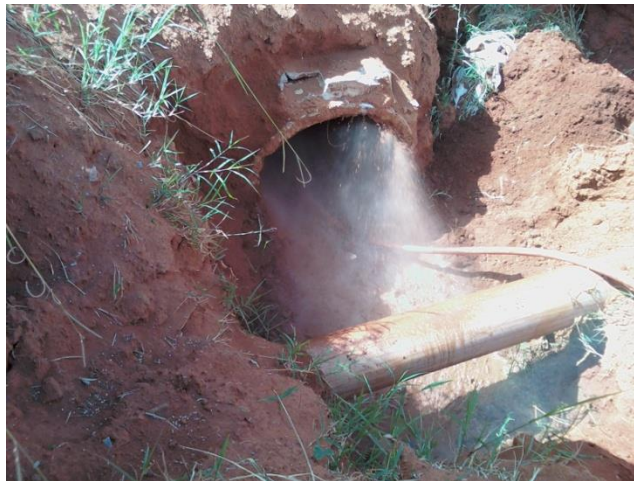
Figura 3. 4 - Desobstrução da rede
