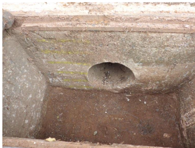
Figura 3. 12 - Boca de lobo (ponto 03 - Iate Clube) com as marcações internas
