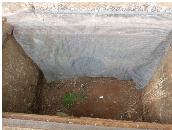
Figura 3. 11 - Tela instalada na boca de lobo
