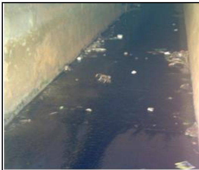
Figura 4. 1 - Galeria denominada de UnB
