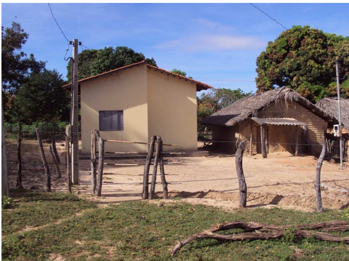
Casa de alvenaria e casa de adobo
