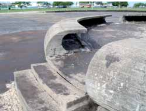
Figura 2.70 - Detalhe da Base da Cruz
