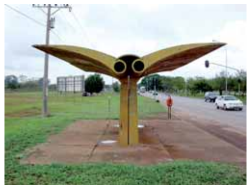
Figura 4.10 - Abrigo Lelé - em 2007
