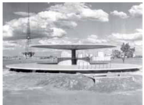
Figura 2.45 - Bar e vestiário
