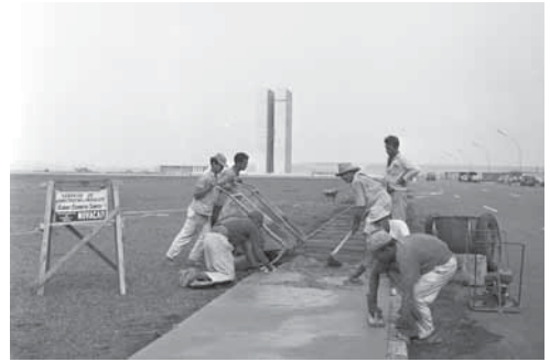
Figura 2.22 - Construção de calçada no canteiro central do eixo monumental - 1964
