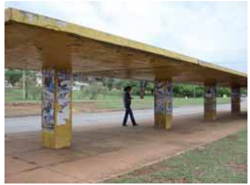
Figura 2.128 - Abrigo em ponto de ônibus
