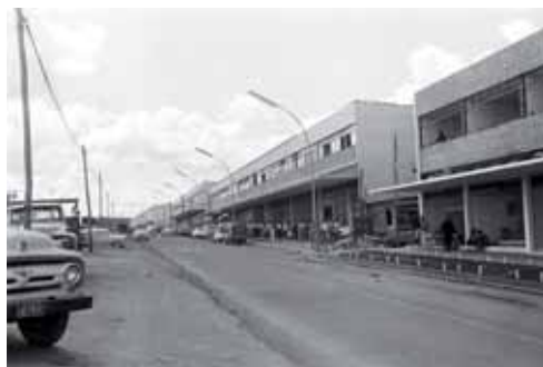
Figura 2.10 - Luminárias na avenida W3 Sul na inauguração da cidade
