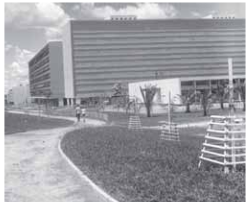
Figura 2.24 - Protetor de Árvore na Superquadra - 1964
