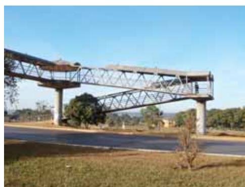
Figura 2.176 - Passarela elevada de pedestres do Zoológico
