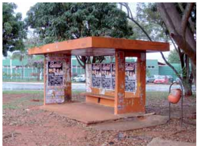
Figura 4.19 - Abrigo Secretaria de Viação e Obras
