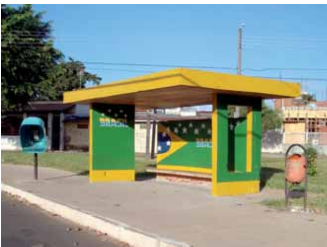
Figura 4.18 - Abrigo Secretaria de Viação e Obras
