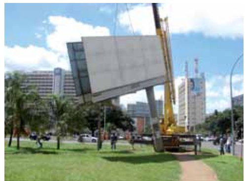
Figura 3.9 - Remoção de Outdoor de área pública no Setor Hoteleiro Sul realizada pela Agência de Fiscalização (Agefis)
