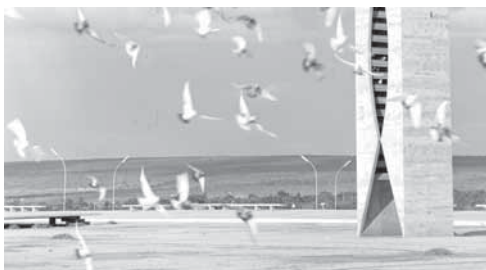
Figura 2.29 - Palanque na Praça dos Três Poderes, no canto inferior esquerdo. Foto de fevereiro de 1965
