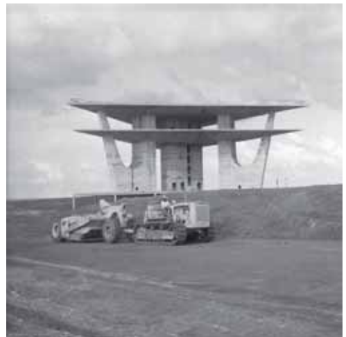
Figura 2.13 - Torre de TV, em 1960, com a base de concreto armado concluída
