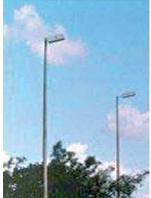
Figura 2.144 - Detalhe da Luminária do Eixo Rodoviário
