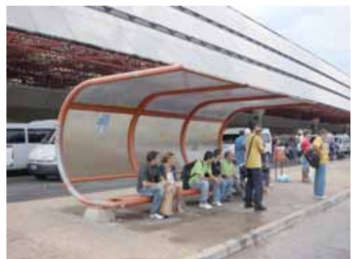
Figura 2.152 - Abrigo em ponto de ônibus modelo Sérgio Parada instalado no Aeroporto Internacional de Brasília
