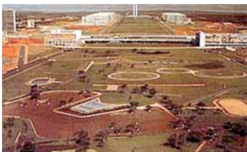
Figura 2.41 - Esplanada da Torre antes da construção do viaduto de ligação da W3 Sul e W3 Norte
