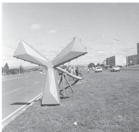
Figura 2.98 - Instalação de luminárias na via L2 Sul
