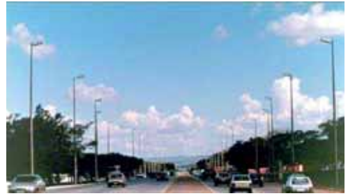
Figura 2.143 - Postes e Luminárias do Eixo Rodoviário
