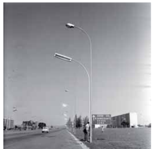
Figura 2.95 - Primeira substituição das Luminárias do Eixo Rodoviário - julho 1977
