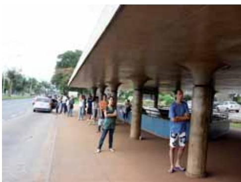
Figura 2.175 - Abrigo do acesso ao Metrô da Estação 114 Sul
