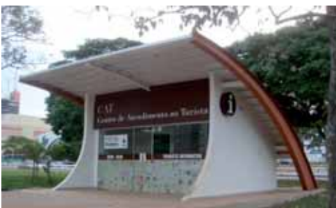
Figura 2.191 - Centro de Atendimento ao Turista no Setor Hoteleiro Sul
