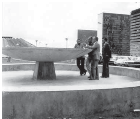
Figura 2.88 - Praça de Pedestre Norte em construção - fev. 1977
