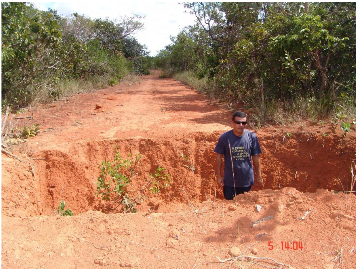
Figura 4.4 – Trincheira em estrada para impedir o trânsito de carros
