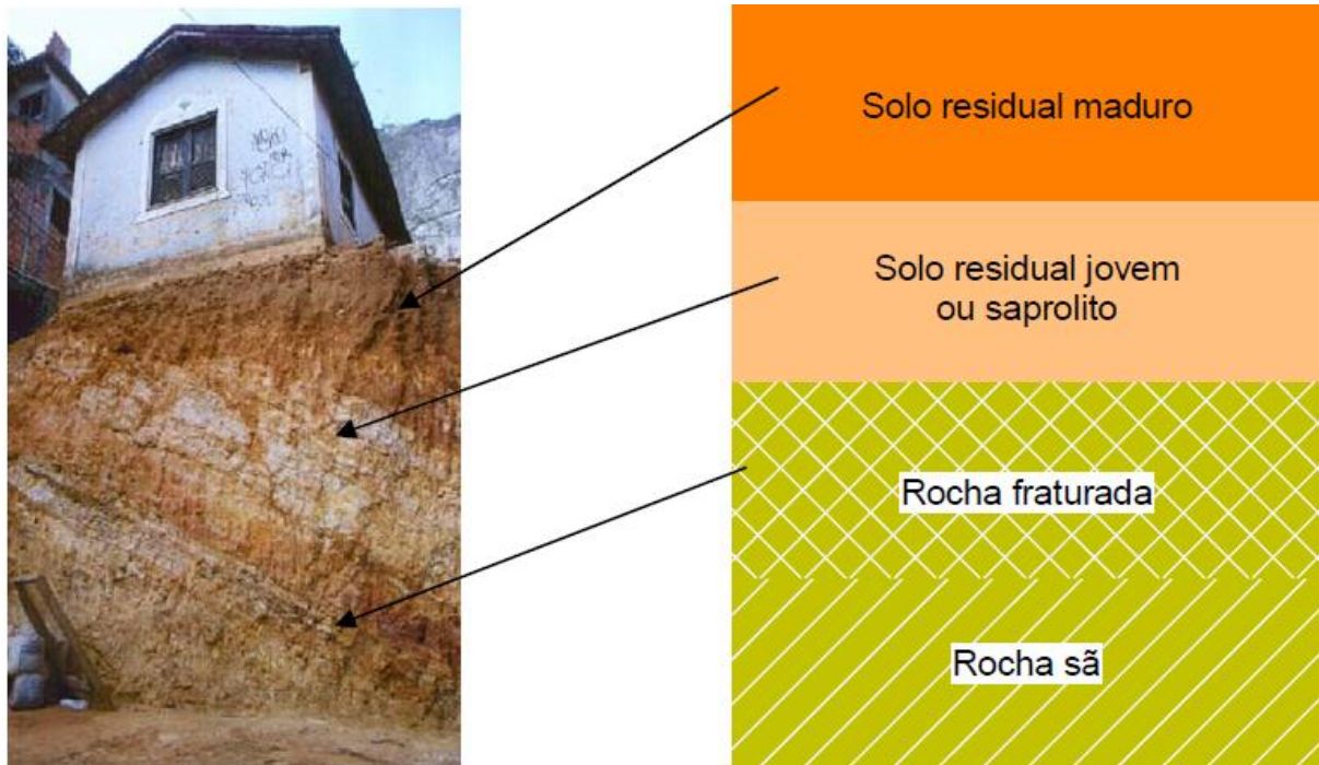
Figura 2.8 – Perfil geotécnico de solo residual desenvolvido sobre gnaiss (Ortigão, 2007)
