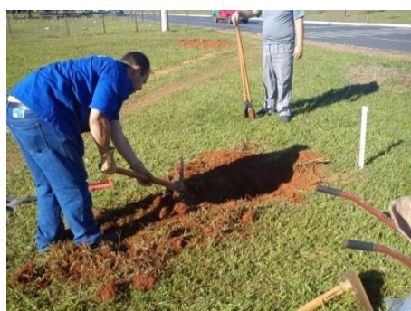
(a) Escavação manual e (b) Poço para coleta.
