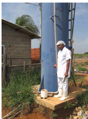
Figura 6.3. Caixa d'água que abastece a agroindústria.
