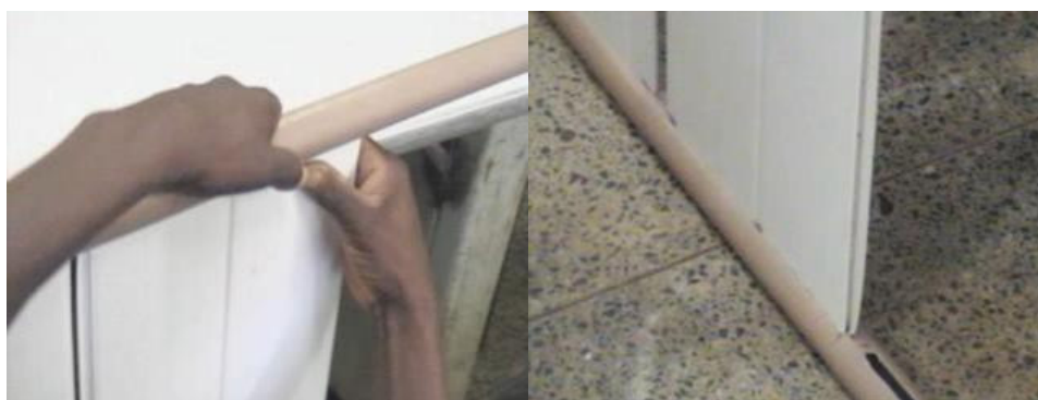
Figura 16 (esquerda) e 17(direita): encaixando as placas no cano. Autor: Antonio Martins Ferreira Neto.
