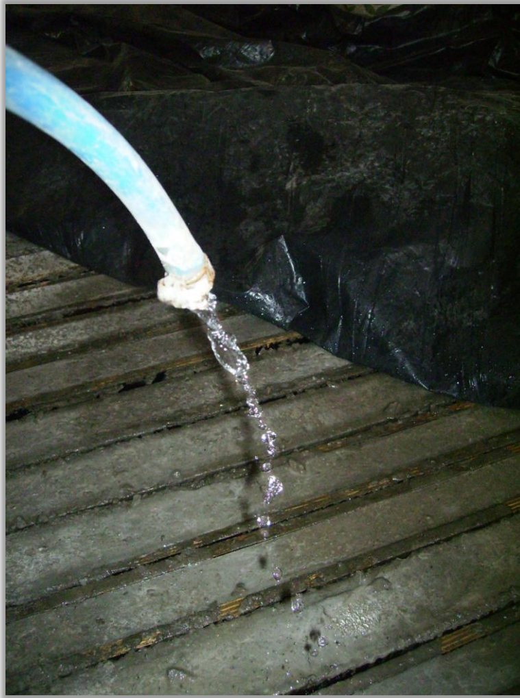
Figura 3.6 – Cura úmida.
