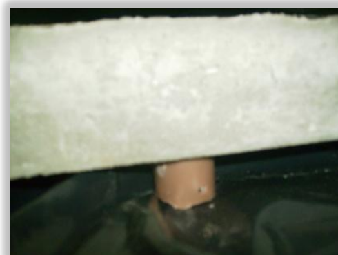
Figura 3.16 – Confecção e posicionamento dos calços de PVC.
