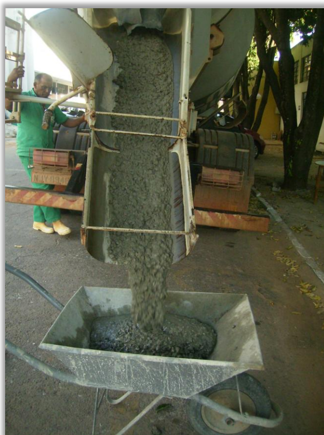
Figura 3.3 – Retirada do concreto do caminhão betoneira.
