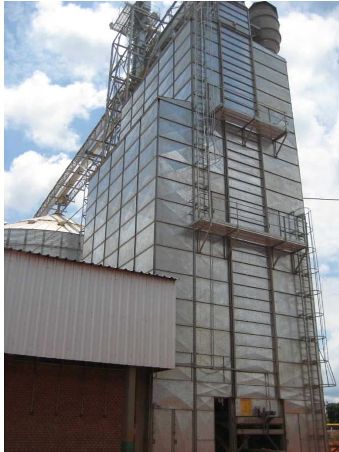
Figura 2.4: Torre onde estão instalados: elevadores, secadores, exaustores, máquinas de limpeza, distribuidores.
