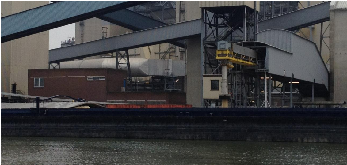
Figura 2.6: Barcaça sendo carregada por uma bica de expedição. Fonte: Própria Autora (2012)
