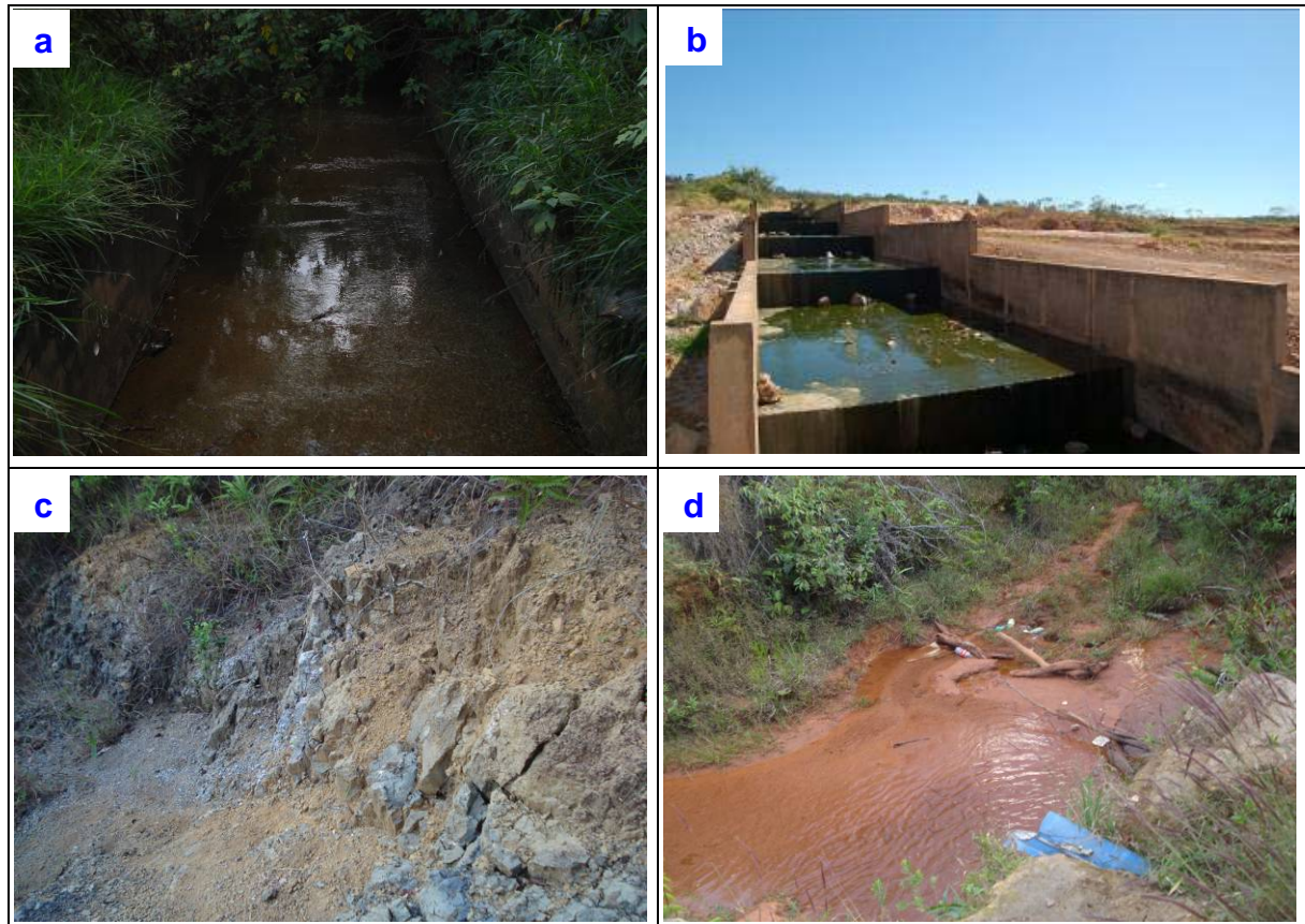
Figura 568 - (a) Galeria de drenagem de águas pluviais localizada na cabeceira do Ribeirão Santa Maria; b) Escadaria com a finalidade de diminuir a energia cinética da água; c) formação de processos erosivos nas margens do Ribeirão Santa Maria; d) assoreamento do leito do Ribeirão Santa Maria.
