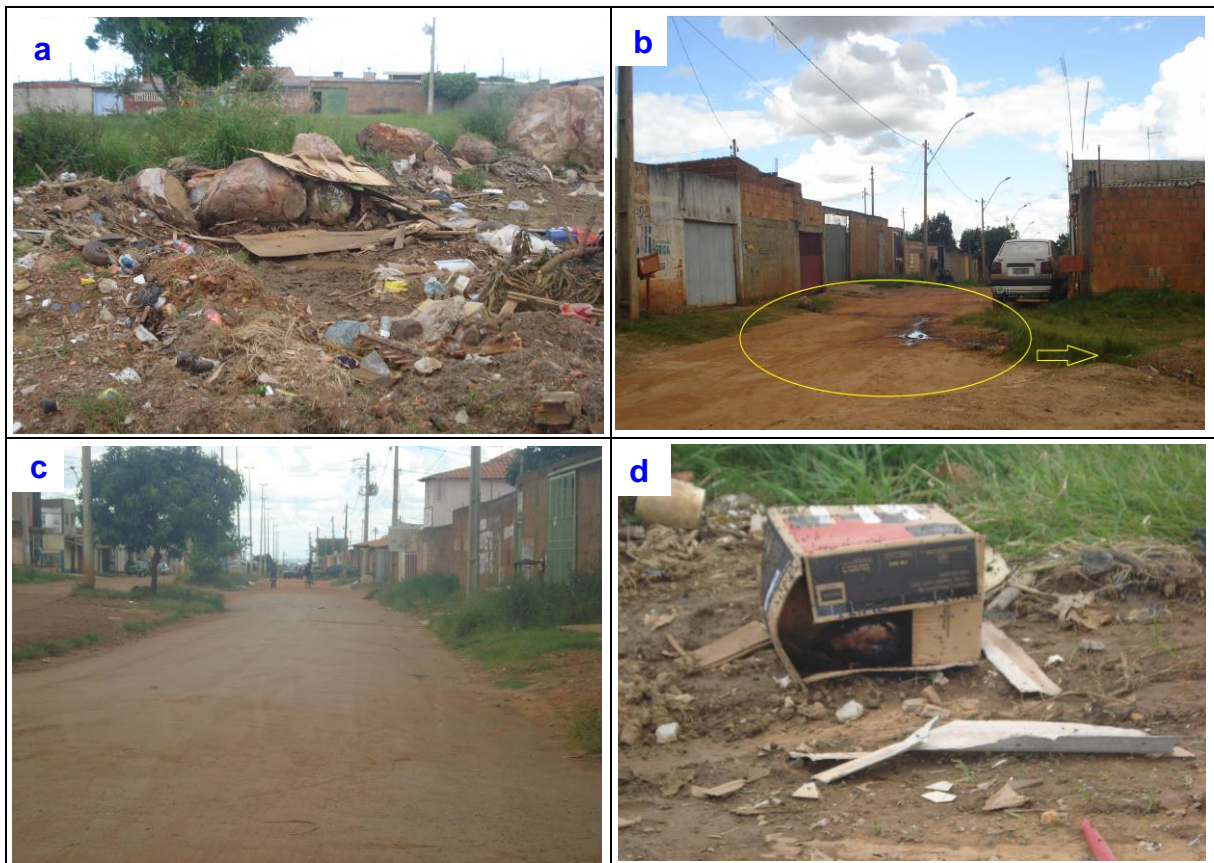
Figura 30 - Avenida principal sem asfaltamento, transbordamento de efluentes de fossas sépticas lançados na rua, despejo de lixo em locais inapropriados e a presença de animais mortos (cachorro) nas proximidades das residências.
