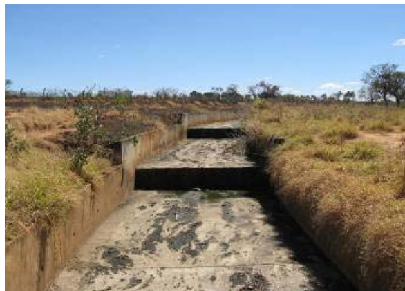
Figura 39 - Biossólidos da CAESB (ETE de Santa Maria) despejado em canal de rede de drenagem de águas pluviais.
