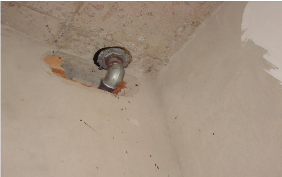
Figura 2.6 – Exemplo de falta de terminalidade em serviços. Tubulação é executada após conclusão do revestimento (foto tirada pelo autor desta Tese).
