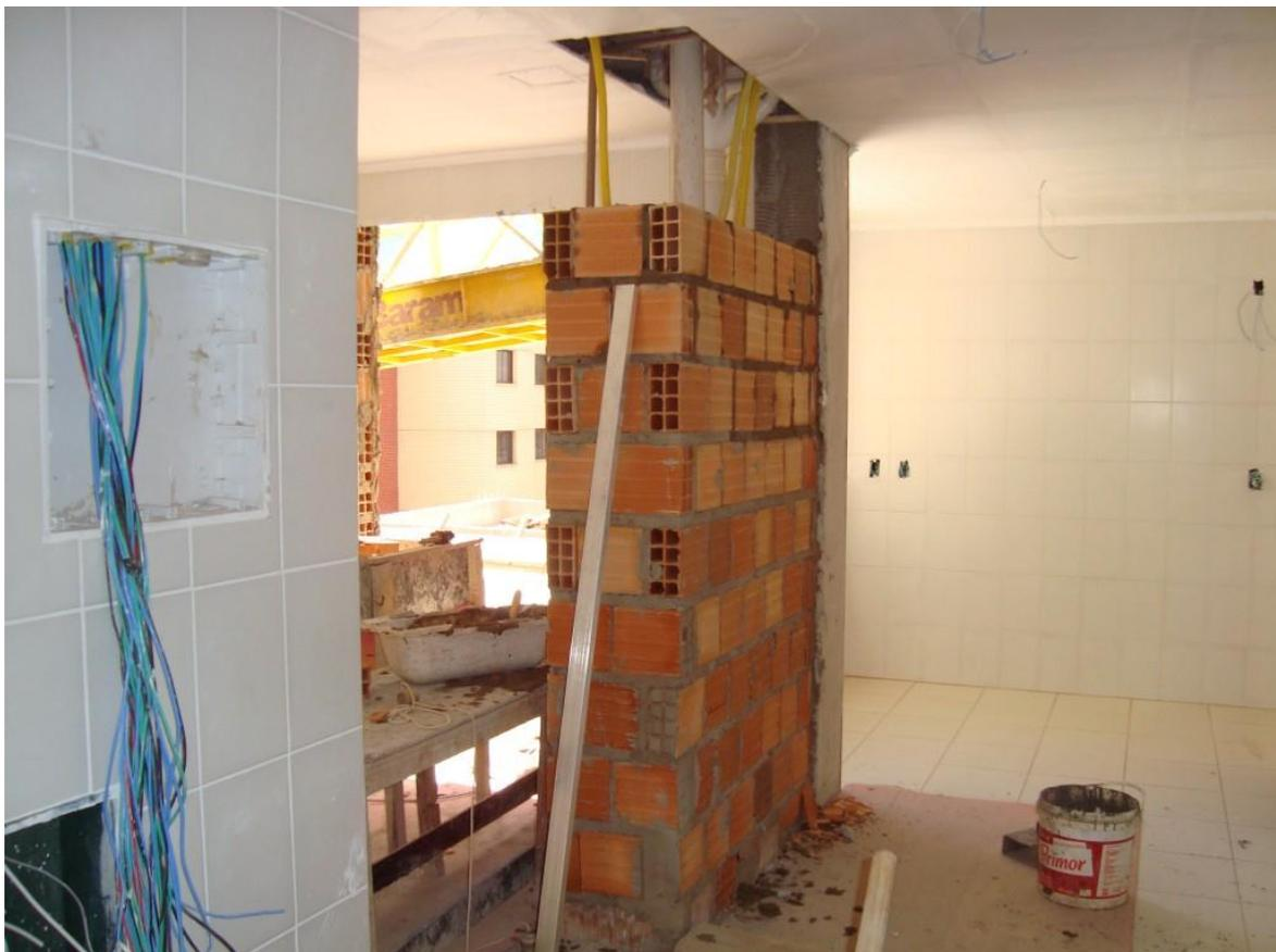
Figura 2.7 – Exemplo de falta de terminalidade em serviços. Fechamento de *shaft* é executado após término do revestimento de cozinha (foto tirada pelo autor desta Tese).
