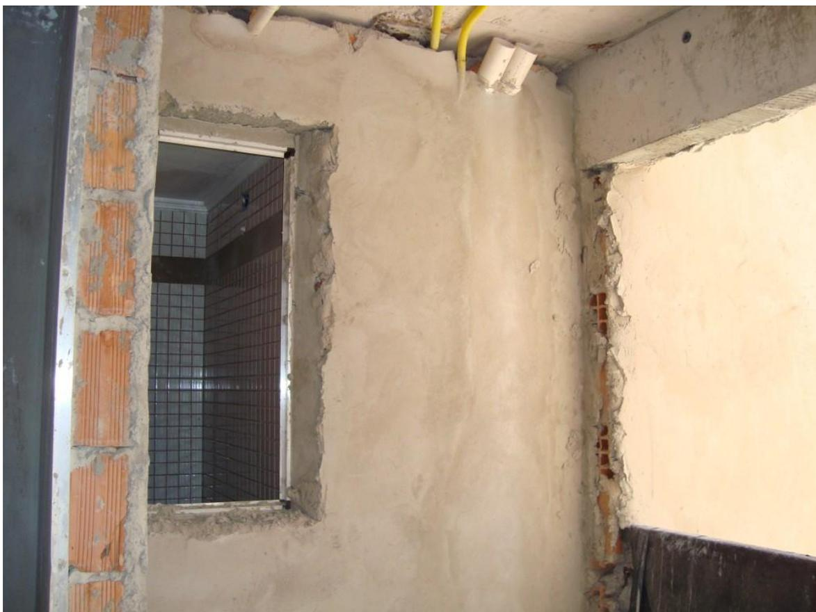
Figura 2.8 – Exemplo de falta de terminalidade em serviços. Colocação de contramarco e requadrção de janela com problemas de seqüência (foto tirada pelo autor desta Tese).
