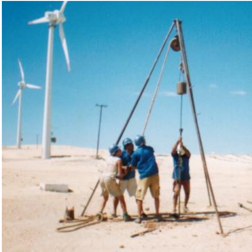
Figura 3.62 – Execução das sondagens à percussão.
