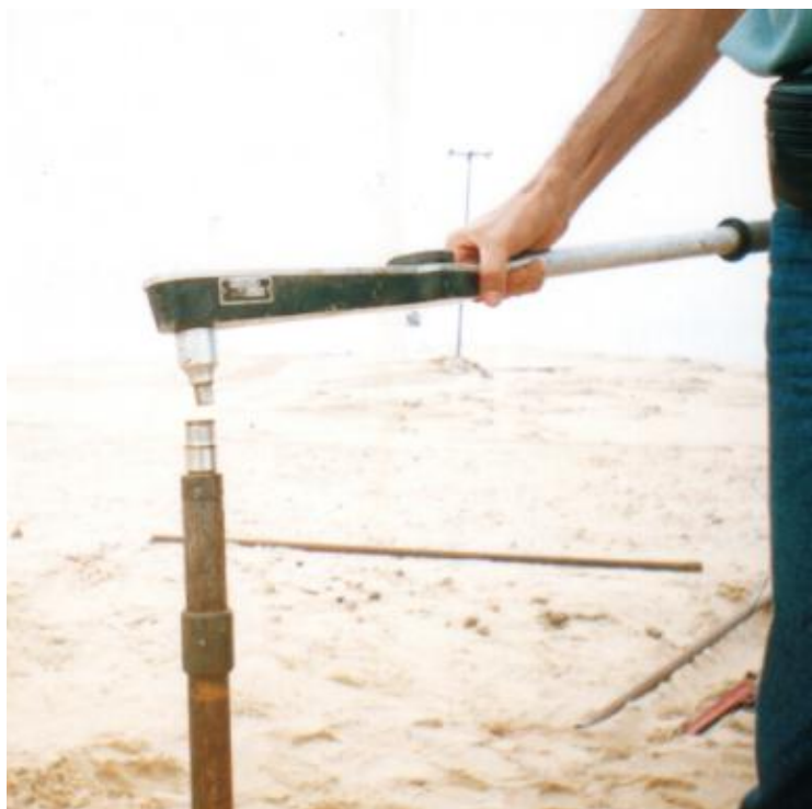
Figura 3.67 - Detalhe da conexão do torquímetro com a haste da composição do equipamento de sondagem à percussão.
