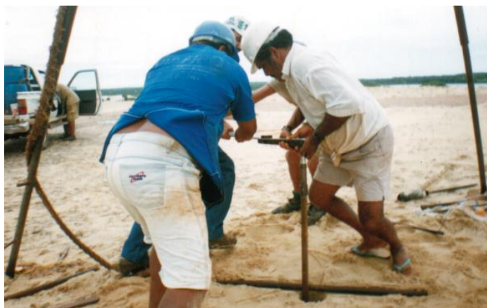
Figura 3.68 - Execução do ensaio de torque.
