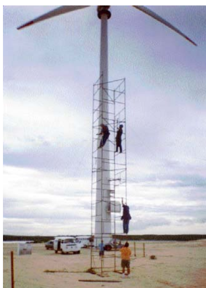
Figura 3.15 – Instalação do anemômetro em um andaime para a realização das medidas anemométricas da Taíba.
