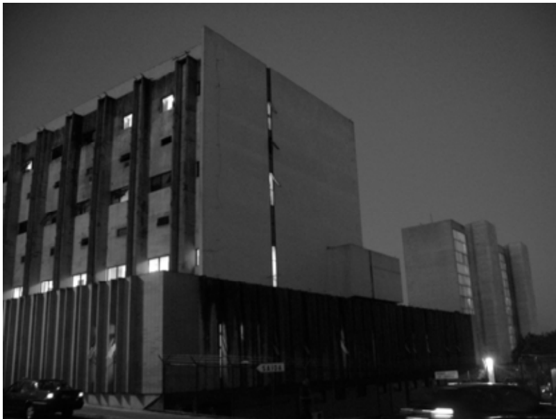
Foto 3: Emergência no centro e Internação à direita no fundo.
