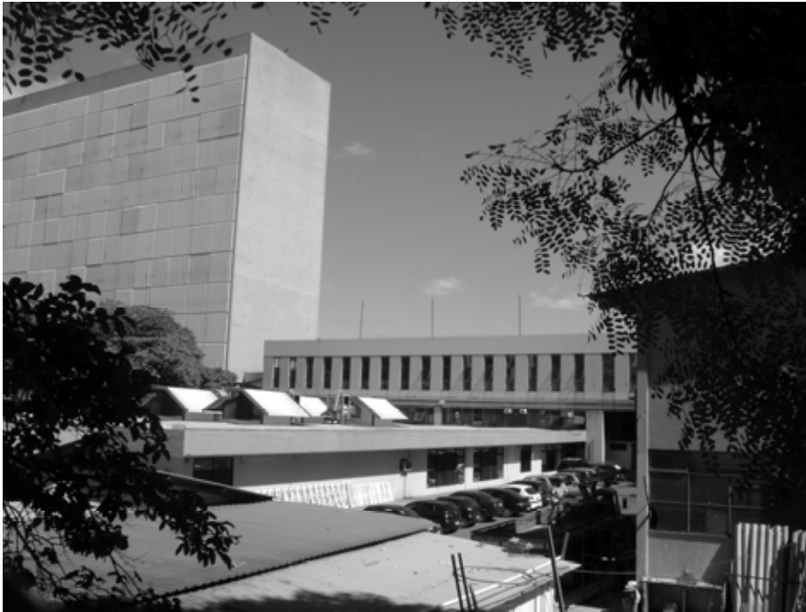
Foto 5: Pavilhão Administrativo no centro e Internação à esquerda.
