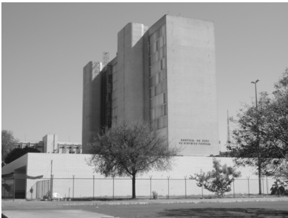
Foto 1: Ambulatório abaixo, Internação no centro e Emergência à esquerda no fundo.
