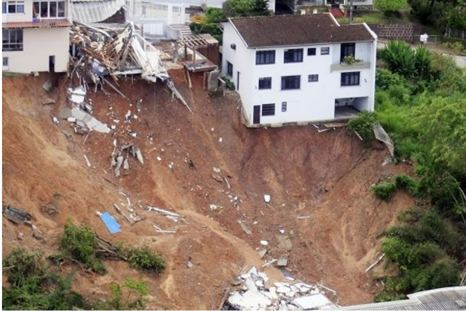
Figura 5. Foto exemplificando escorregamento rotacional em no Rio de Janeiro, 2011.
