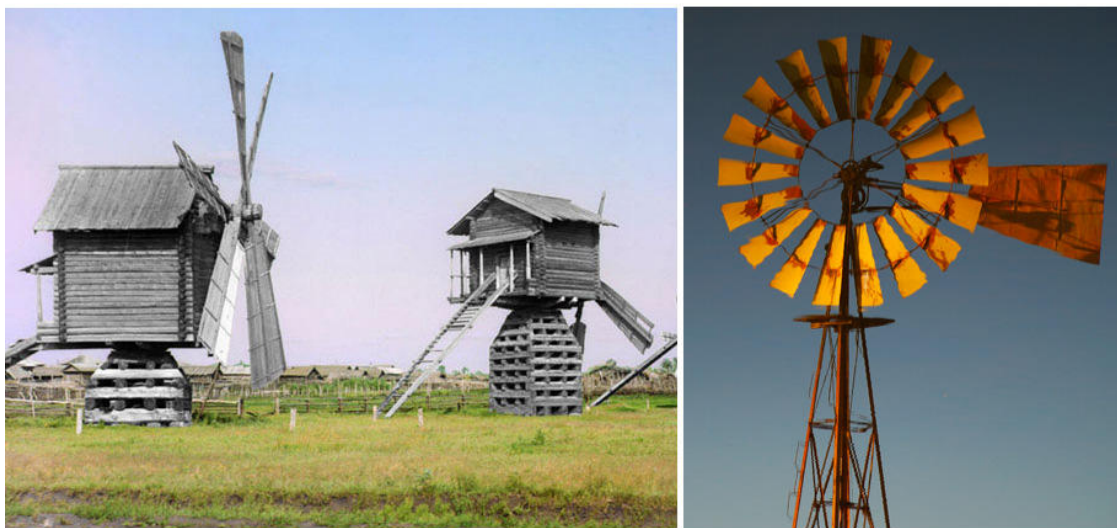
Figura 2-1 – À esquerda, foto de moinhos no verão siberiano de 1912, (Prokudin-Gorskii, 1912). À direita, cata-vento utilizado para bombeamento de água em salineiras no Brasil e seu dispositivo de segurança, pá à direita do rotor.
