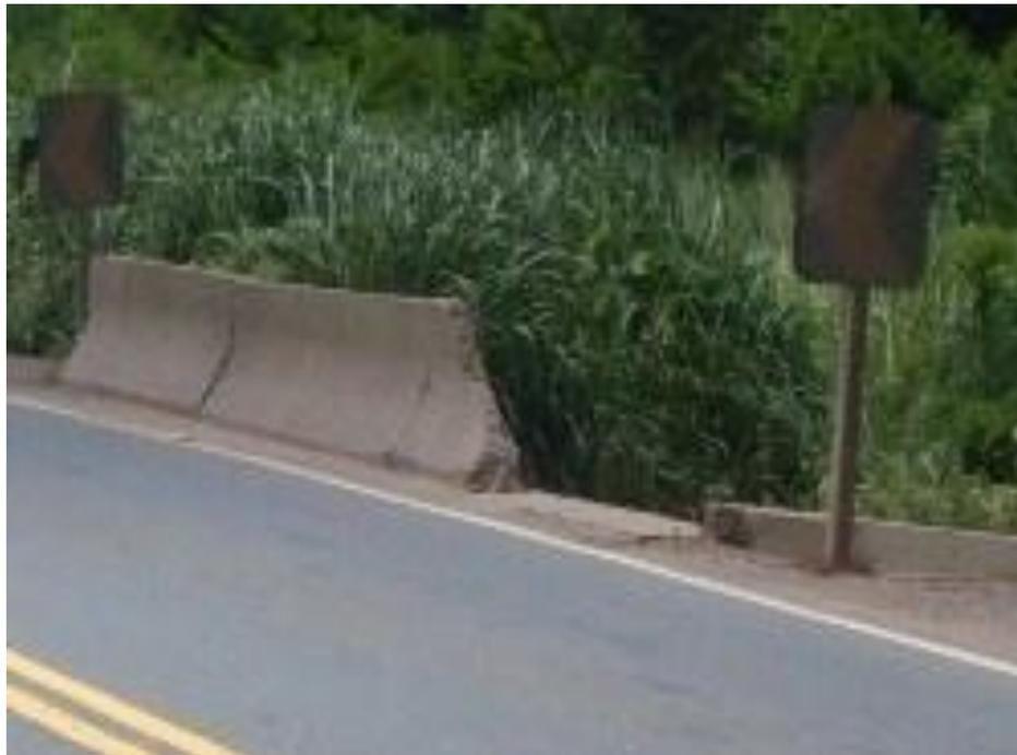
Figura A.8 – Tabuleiro com proteção lateral danificada(DNIT, 2010)
