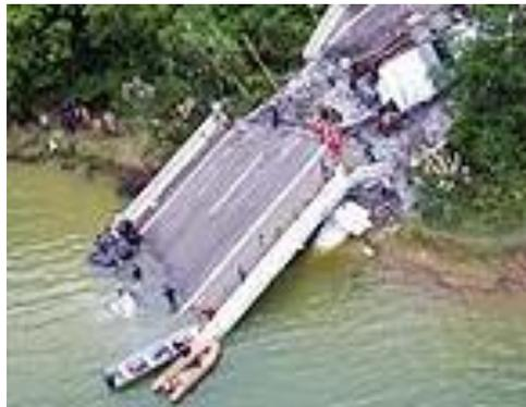
Figura 1.3- Desabamento de um trecho da ponte Capivari (Folhaonline, 2005).
