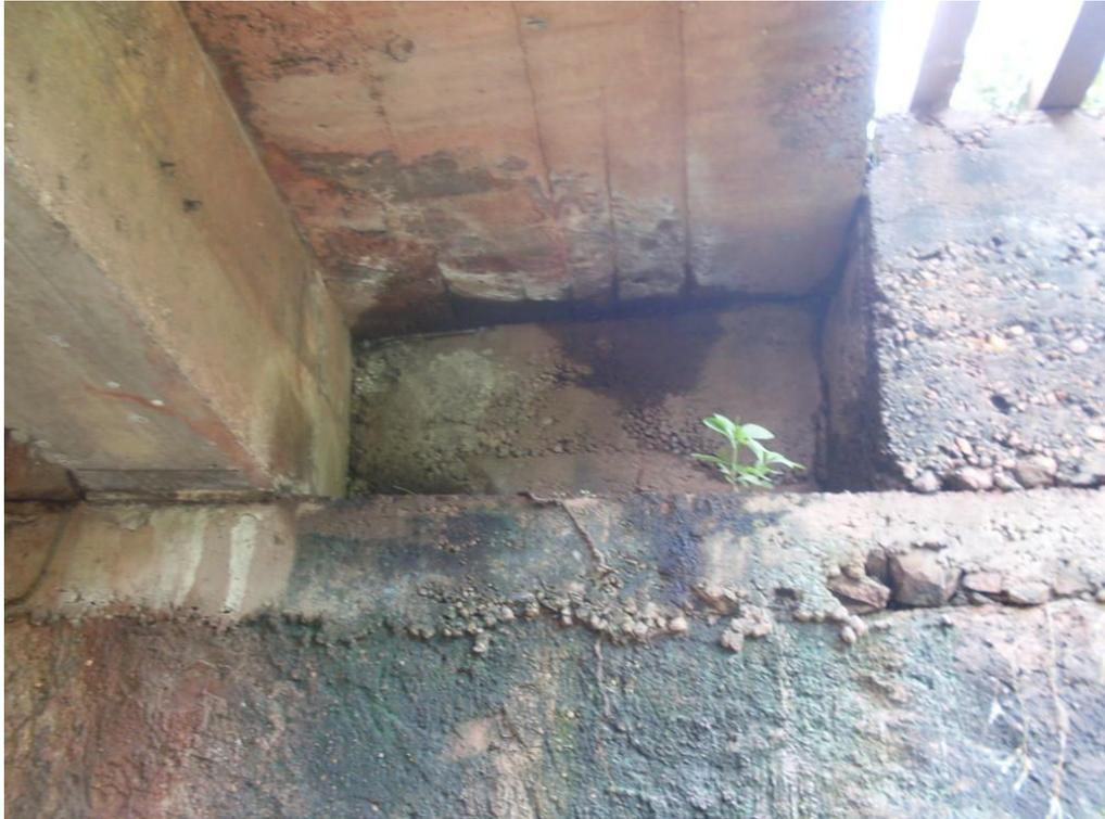
Figura A.7 – Ferragem exposta na parte inferior do tabuleiro (DNIT, 2010)
