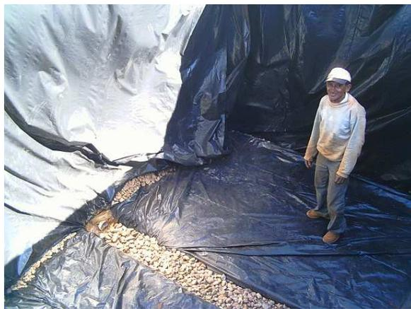
**Figura 3.8** – Sistema de impermeabilização e drenagem de lixiviados da célula experimental.
