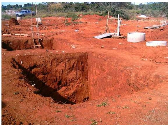
**Figura 3.7-** Vista panorâmica de duas células experimentais (etapa escavação).
