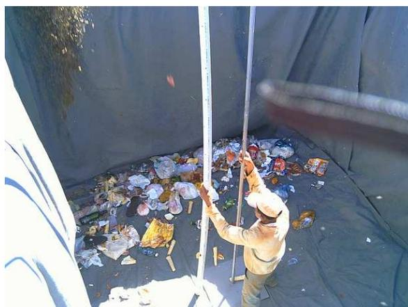
**Figura 3.9** – Vista interior da célula experimental no início do enchimento do RSU.
