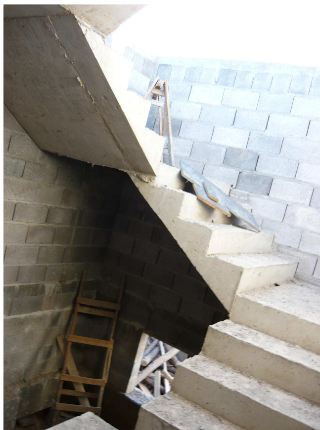
Figura 3.35: Exemplo de escada de concreto armado moldada in loco . Fonte: Foto do autor.
