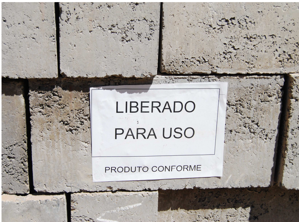
Figura 5.30: Triagem de blocos estruturais. Fonte: Foto do autor.
