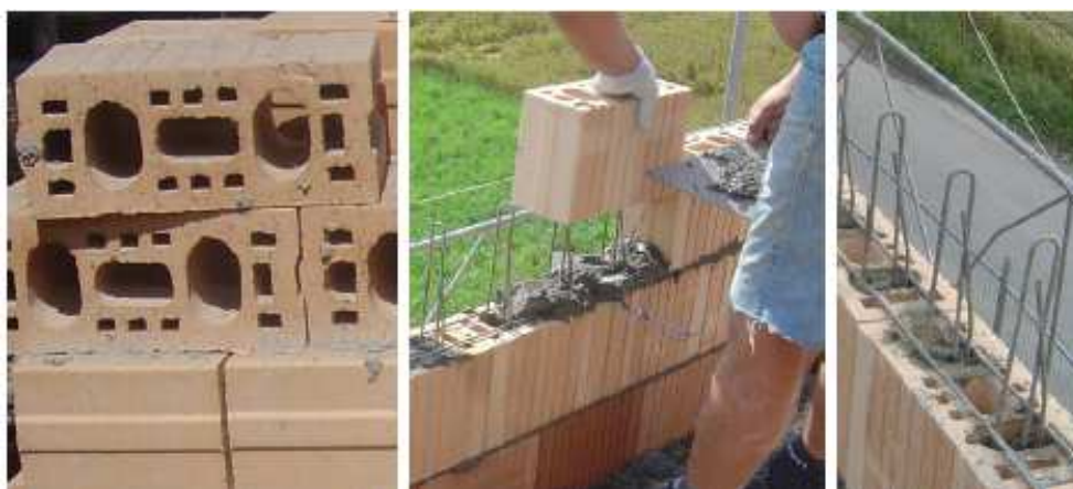
Figura 5.4: Solução suíça para alvenaria armada. Fonte: LOURENÇO, 2007.
