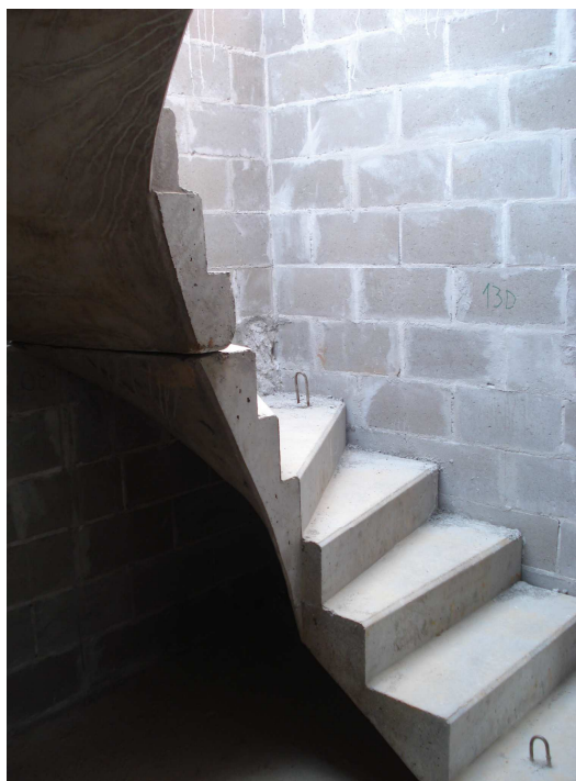
Figura 3.36: Exemplo de escada pré-moldade de concreto armado. Fonte: Foto do autor.
