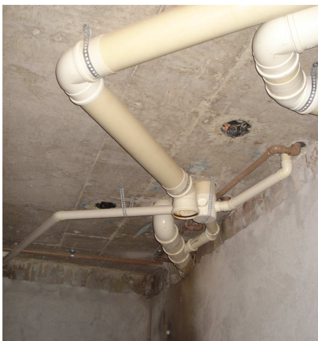
Figura 3.32: Tubulação correndo por baixo da laje. Fonte: Foto do autor.
