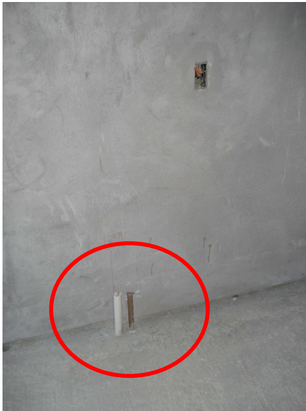
Figura 5.28: Instalações hidro-sanitárias fora das paredes. Fonte: Foto do autor.
