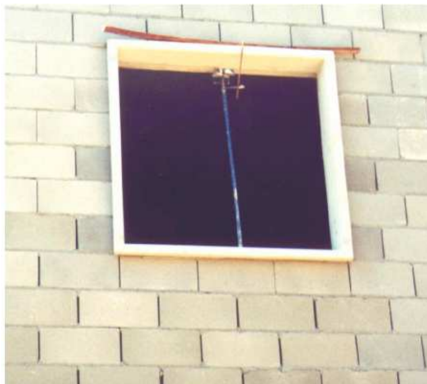
Figura 3.27: Contra-marco de argamassa armada. Fonte: SANTOS, 1998
