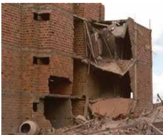
Figura 6.1: Escombros de um edifício em construção em alvenaria resistente de blocos cerâmicos de vedação. Fonte: HANAI e OLIVEIRA, 2002.
