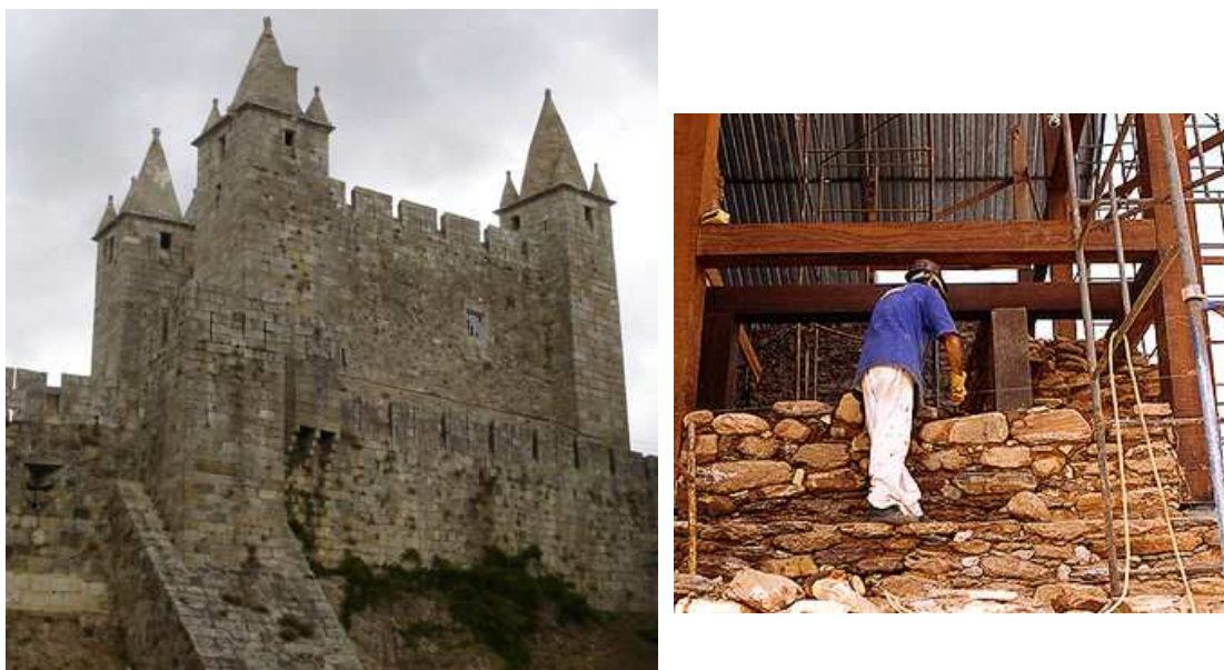
Figura 2.4: Exemplos de cantaria de pedra: à esquerda, Castelo de Santa Maria da Feira, no distrito de Aveiro, Portugal; à direita, reconstrução da Igreja Matriz de Pirenópolis – GO. Fontes: www.wikipedia.org e www.pirenopolis.tur.br
