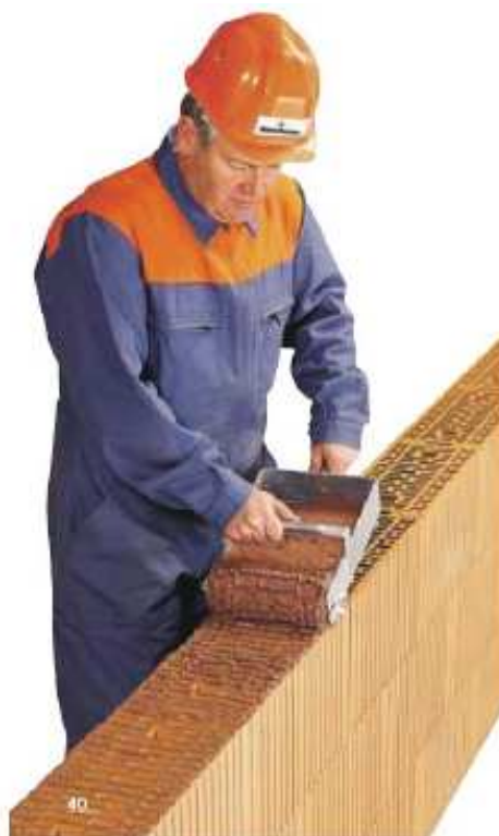
Figura 5.9: Aplicação de argamassa na Alvenaria Rolada. Fonte: www.wienerberger.com
