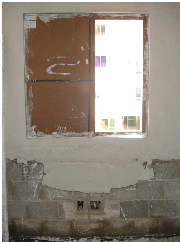
Figura 5.25: Aplicação de revestimento de gesso sobre as paredes e utilização de janelas prontas e com vidro. Fonte: Foto do autor.
