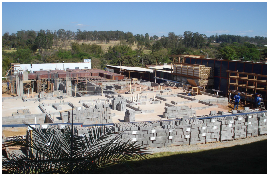
Figura 5.24: Edifício em construção em alvenaria estrutural voltado para a classe média em Taguatinga – DF. Fonte: Foto do autor.
