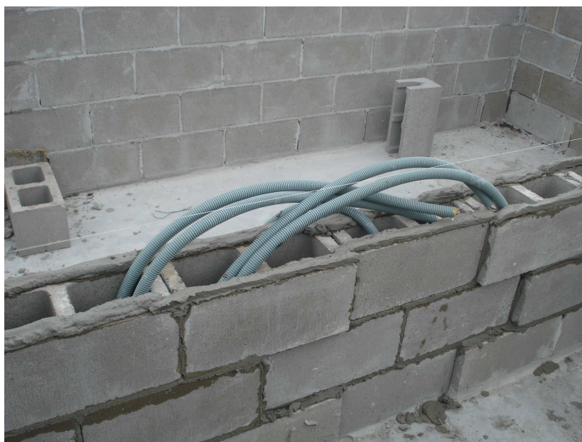
Figura 3.29: Lançamento dos eletrodutos concomitantemente ao assentamento dos blocos. Fonte: Foto do autor.
