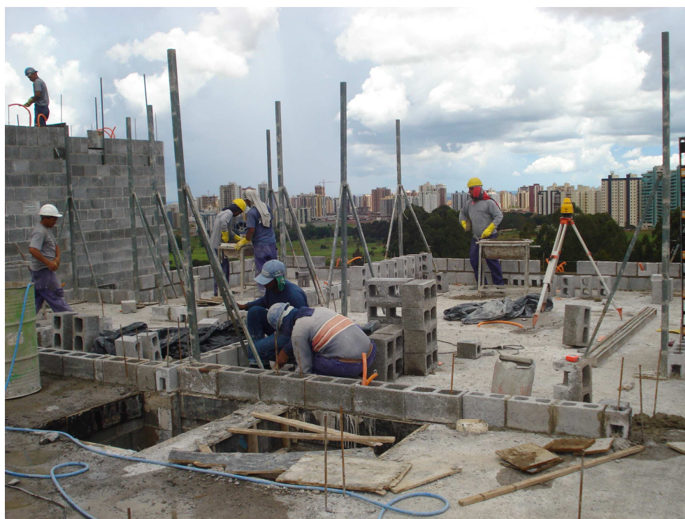
Figura 5.26: Operários assentando os blocos estruturais. Fonte: Foto do autor.
