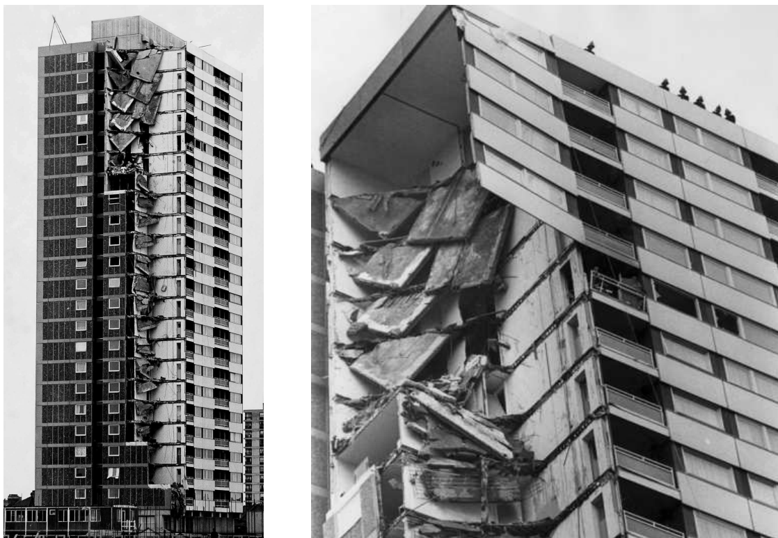
Figura 6.2: O desabamento do edifício Ronan Point (1968) Fonte: www.wikipedia.org
