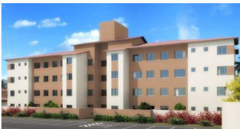
Figura 5.33: Edifício de apartamentos em alvenaria estrutural em Santa Maria-DF. Fonte: Direcional Engenharia.
