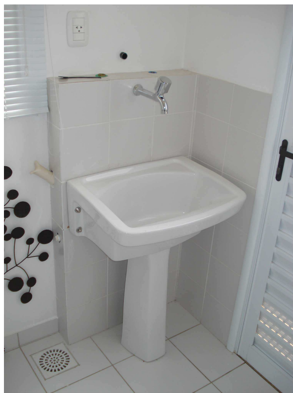
Figura 3.34: Enchimento externo para ocultar instalações fora da parede estrutural. Fonte: Foto do autor.
