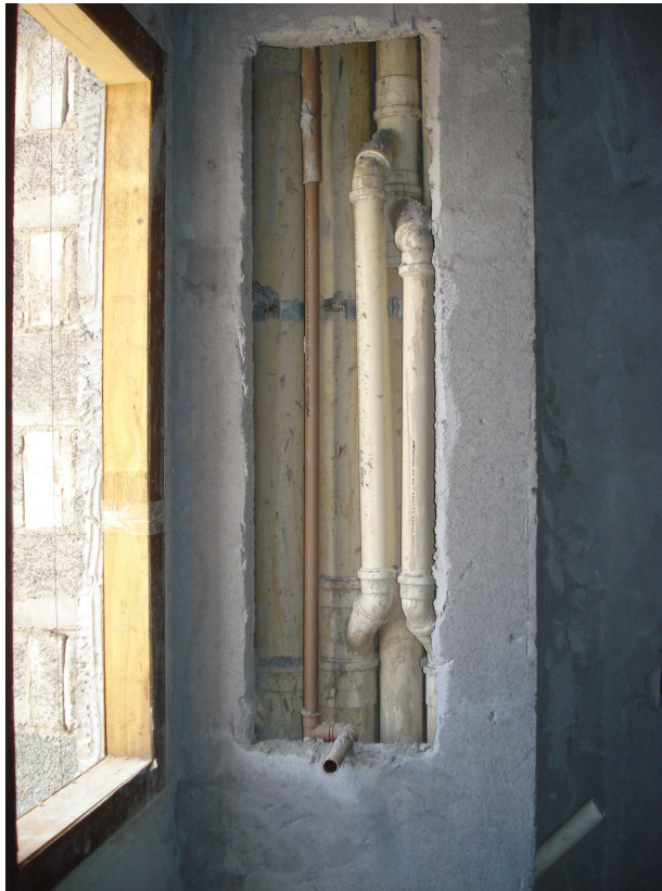
Figura 5.27: Uso de shafts para descida de tubulações. Fonte: Foto do autor.
