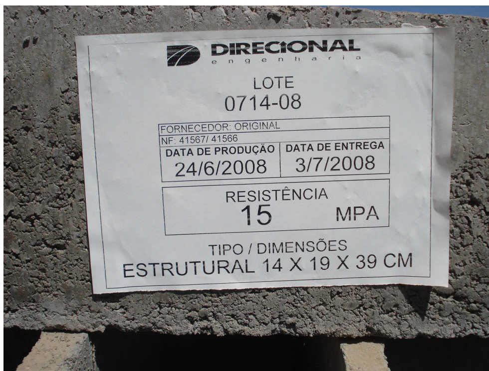
Figura 5.29: Triagem dos blocos estruturais. Fonte: Foto do autor.
