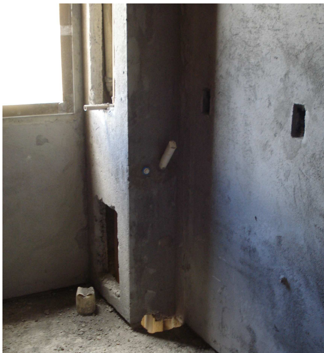
Figura 3.31: Shafts para a distribuição vertical da tubulação. Fonte: Foto do autor.
