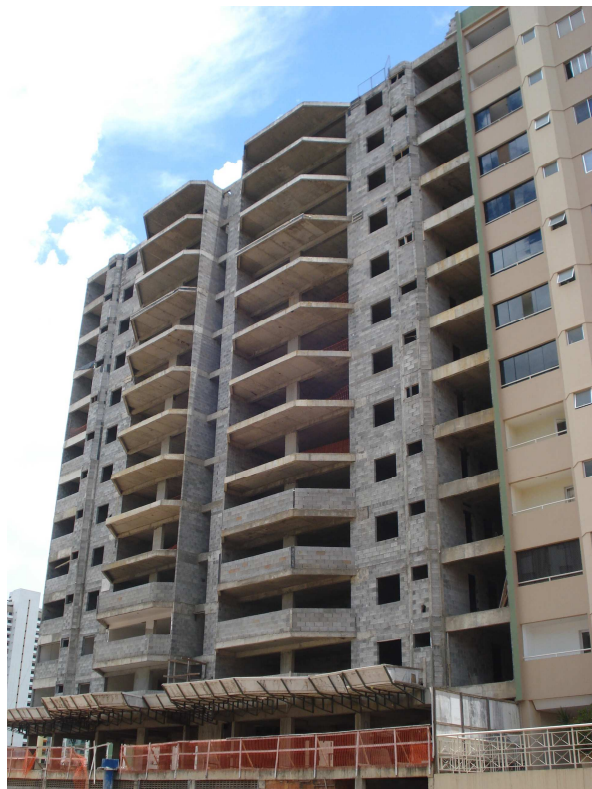
Figura 5.23: Edifício em construção em alvenaria estrutural voltado para a classe média em Águas Claras – DF. Fonte: Foto do autor.
