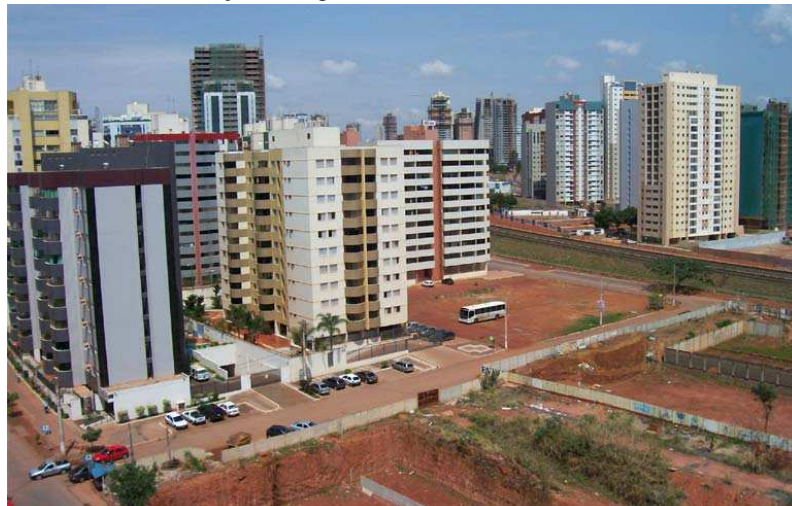
Figura 5.18: Novos canteiros de obra em Águas Claras – DF. Fonte: Administração de Águas Claras.
