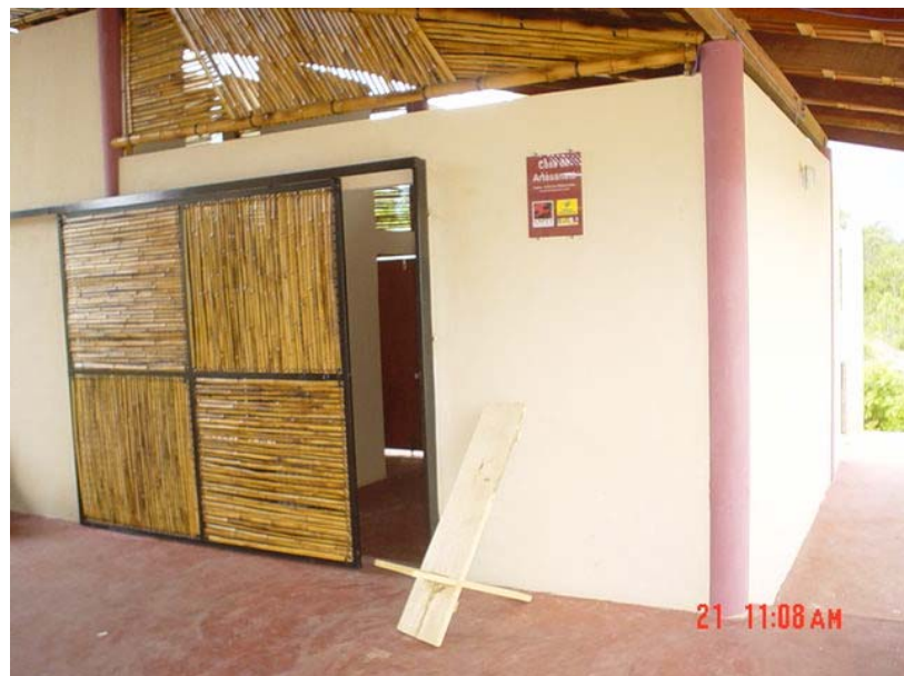
Foto 45. Vista parcial da Casa do Artesanato Krahô .
