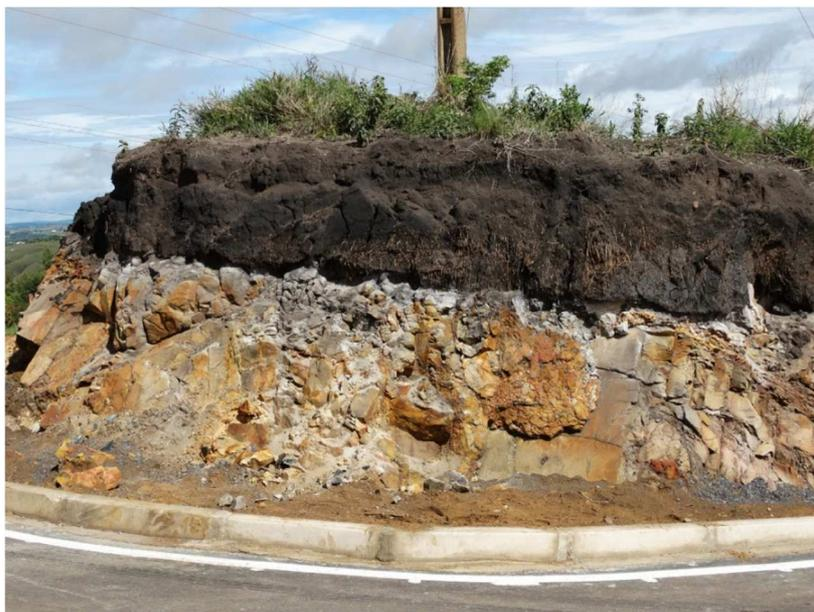
Figura 3. 2 - Vista em corte de estrada de solo sobre material rochoso que pode apresentar deficiência de drenagem. Foto: Rodrigo Studart Corrêa.
