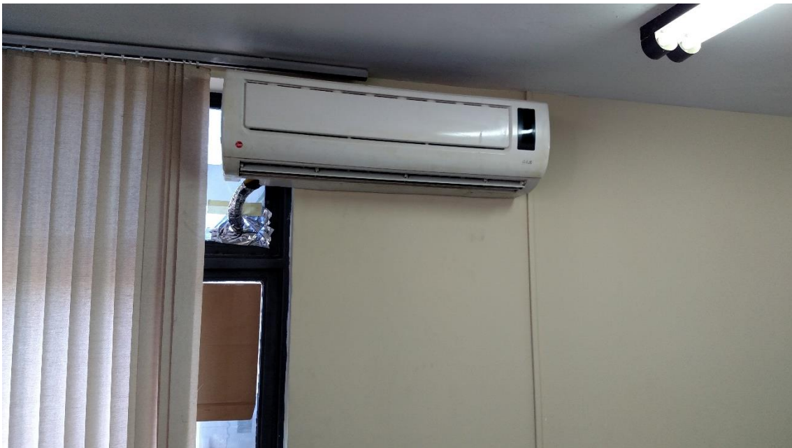
Sistema de ar-condicionado (splits)
