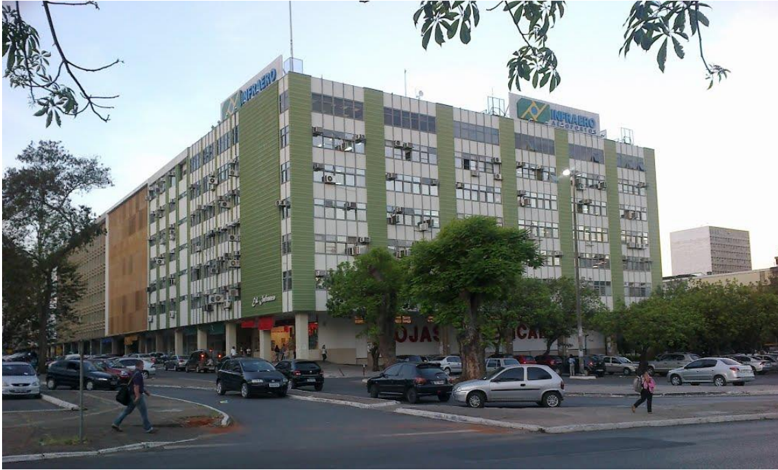
Fachadas dos edifícios Infraero e Centro Oeste
