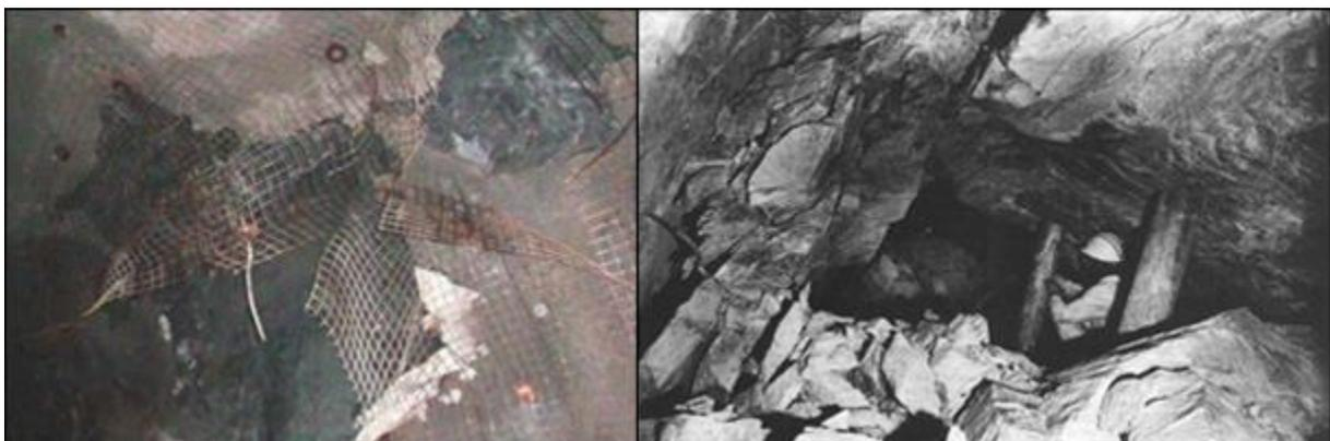
Figura 1.1. Fotografia do *rockburst* acontecido em túneis: explosão-deformação, ejeção de lascas superficiais de rocha (esquerda), e colapso de arco, queda de grandes blocos desde o teto da escavação (direita). Tomadas de Kaiser & Cai (2012) e Ortlepp & Stacey (1994), respectivamente.
