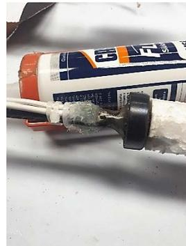
g) Proteção mecânica com silicone
