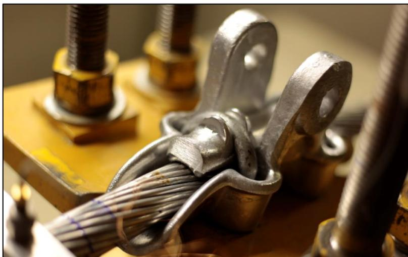
**Figura 4.15 - Grampo de suspensão posicionado.**
