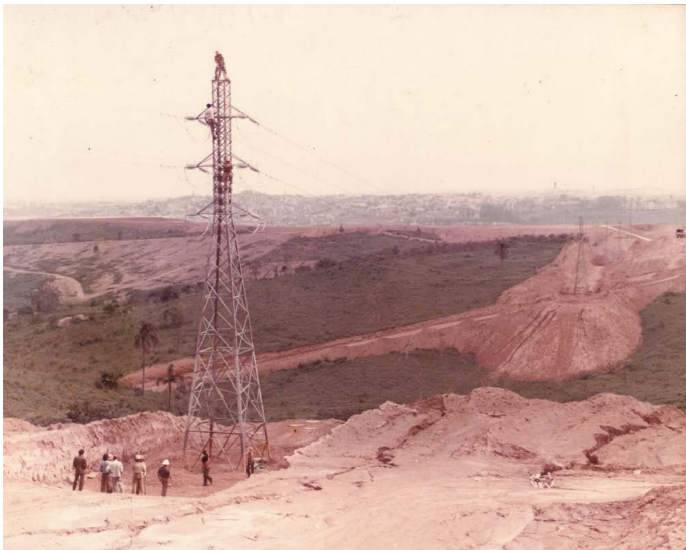
Figura 67. Instalação da rede elétrica de alta tensão na área do empreendimento. Arquivo Histórico de Barueri.
