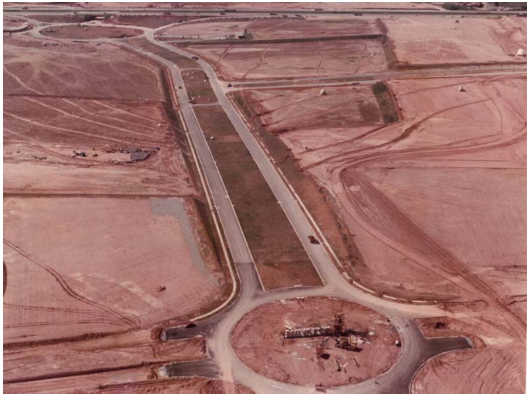
Figura 64. Vista aérea da Avenida Rio Negro com a rodovia Oeste (Castello Branco) ao fundo. Arquivo Histórico de Barueri.
