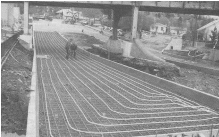
**Figura 2.4.**(a) Geossintético energético (geocomposto instalado em um túnel de energia) (Brandl, 2006). (b) Pavimento Geotérmico no Oregon, Estados Unidos (Lund, 1999).
