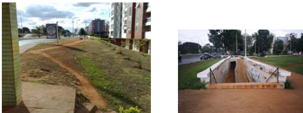
Figura 3.27: Acesso à passagem subterrânea da SQN 213 (E) Entrada da passagem subterrânea (D) Fonte: Fotografias da pesquisadora
