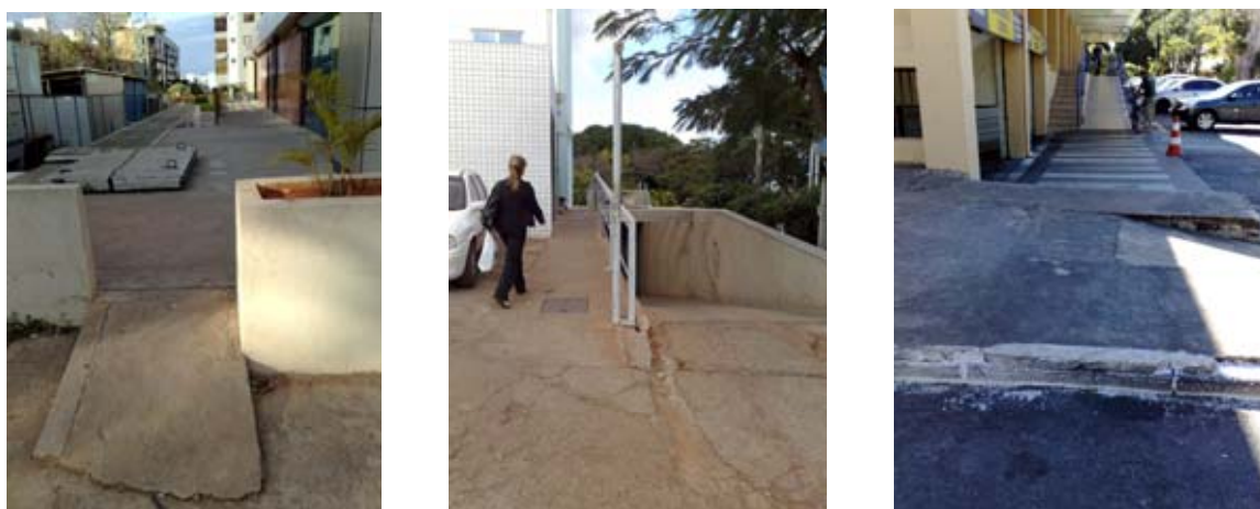
Figura 3.30: Exemplos de obstrução de passagens de pedestre II
