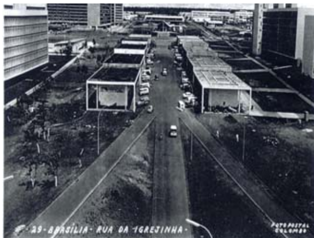
Figura 3.14: Vista do CLS 107/108 Fonte: arquivo da pesquisadora
