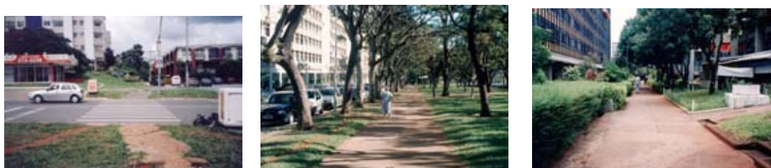
Figura 5.16 Partes do 7º CT - Fitas de passeio junto das superquadras (E) SQN 100/300- passeio fora do padrão/faixa de pedestre/ ausência do passeio e obstrução (M) Passeio padrão na SQS 300 - (D) Passeio invadido por vegetação na SQN 300
