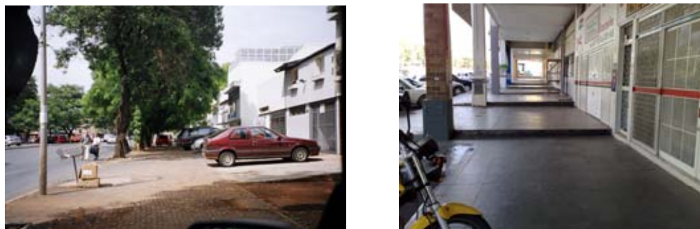
Figura 5.9: Partes do 7º CL - Caminho ao longo da via W3 junto das quadras 700 (E) Quadras 700 Sul; (D) Quadras 700 Norte Fonte: Fotografias da pesquisadora
