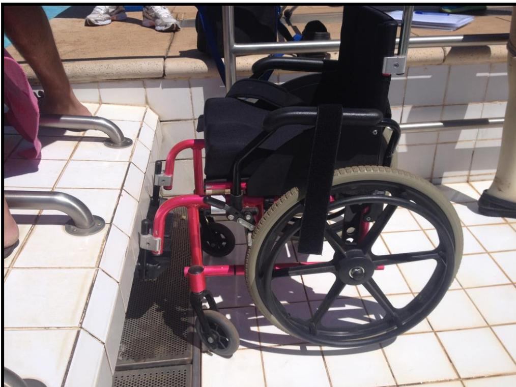
**Foto 16: Distância entre o assento da cadeira e a parede de transferência**
