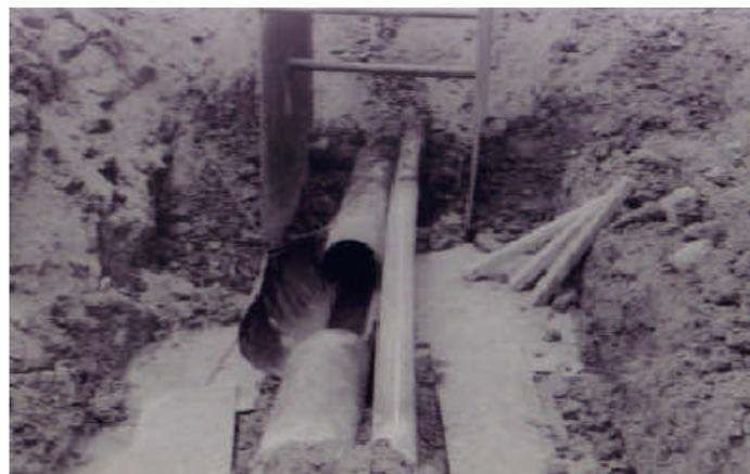
Figura 2.12. Ruptura de tubulação de 20" de diâmetro por impacto de máquina de escavação em Indianápolis, Indiana (modificado - National Transportation Safety Board, 1999).
