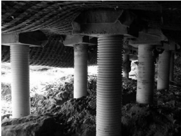
Figura 2.5. Vista da base de um aterro estaqueado reforçado com geossintéticos (geogrelha e geotêxtil não tecido) (Dalen, 2008 citado por Den Boogert, 2011).
