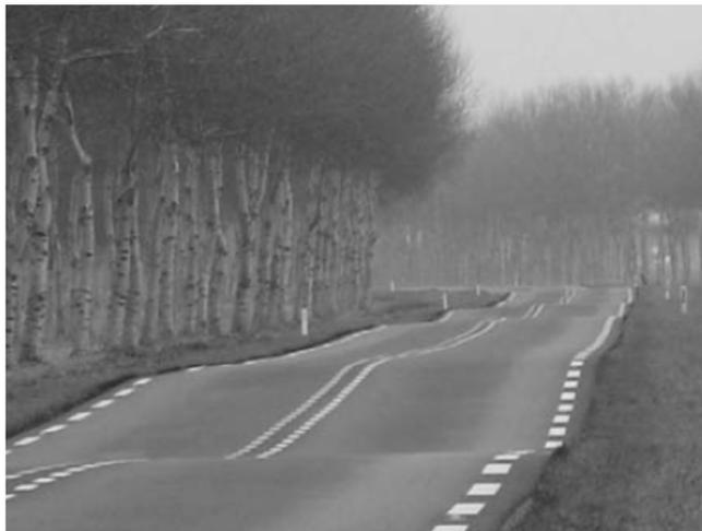
Figura 1.1. Estrada pavimentada com recalques diferenciais significativos (Den Boogert, 2011).
