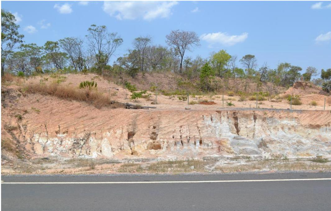
**Apêndice 34:** Solo exposto e formação de sulcos no talude de corte às margens do trecho que não possuía pavimentação. Registrado em 18/09/2016.
