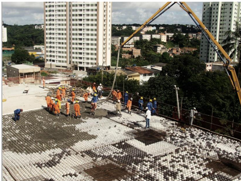
Figura 2-3 Construção da sede da Empresa Odebrecht Brasil, com lajes BubbleDeck ( BUBBLEDECK BRASIL , 2014)
