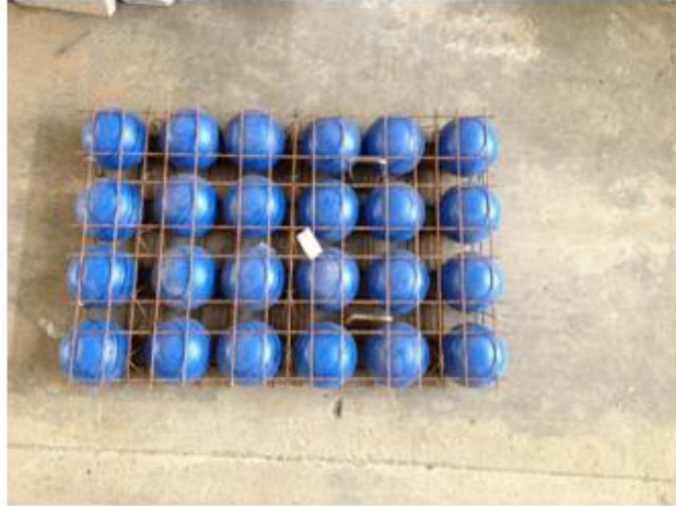
(b) Armação e montagem laje BD28-F2
