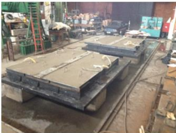
(e) Concretagem final e cura
