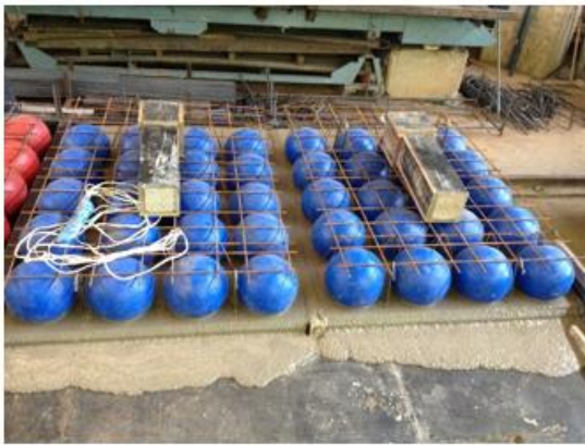
(c) Concretagem das pré-lajes pré-moldadas
