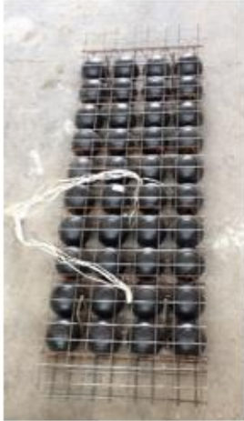
(a) Armação e montagem laje BD28-F1
