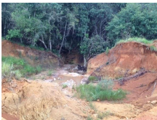
Figura 3 - Erosão próxima aos conjuntos habitacionais provocada pela ocupação urbana irregular na Cidade Ocidental.
