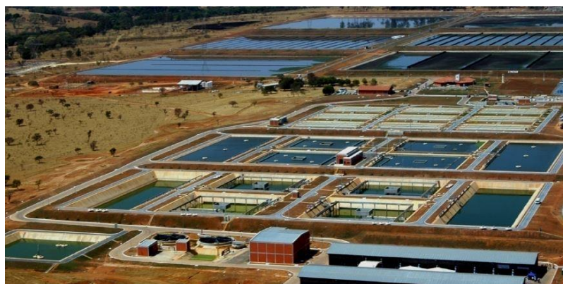
Figura 17 - Vista da ETE Samambaia ao fundo e na frente a ETE Melchior (CAESB, 2013)
