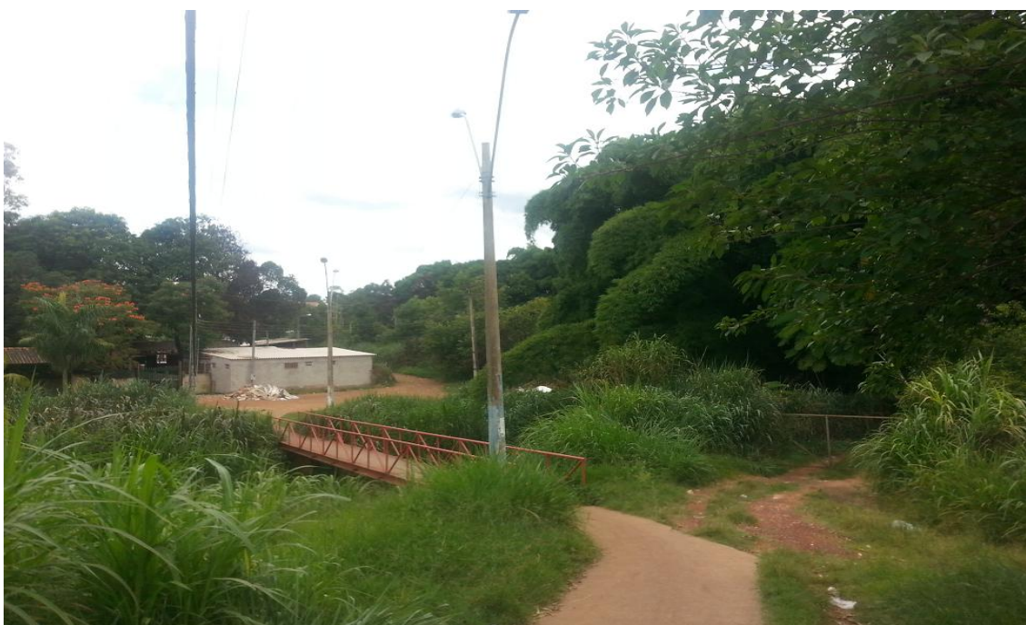
Foto 4 – Ponte de pedestres com acesso ao Núcleo Bandeirante na Vila Cauhy – Realizada em 05/10/2014.
