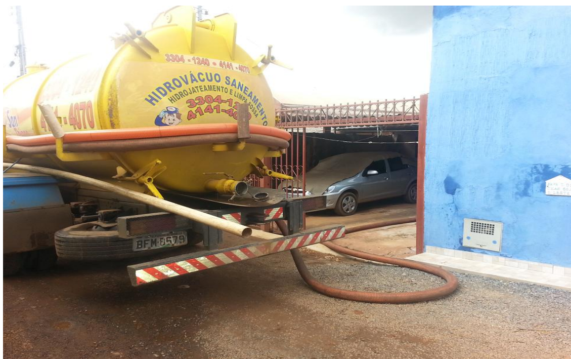
Foto 2 – Fossa Séptica - Esgotamento Sanitário na Vila Cauhy – Realizada em 05/10/2014.
