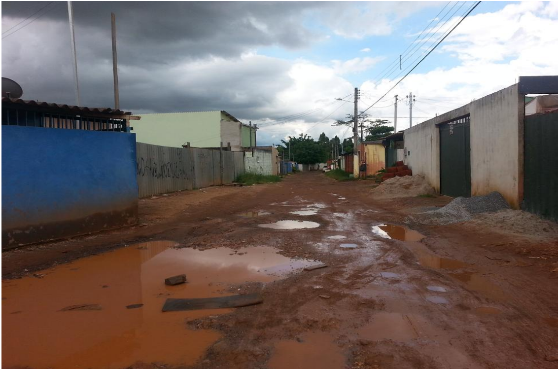
Foto 5 – Ausência de Pavimentação Asfáltica na Vila Cauhy – Realizada em 05/10/2014.
