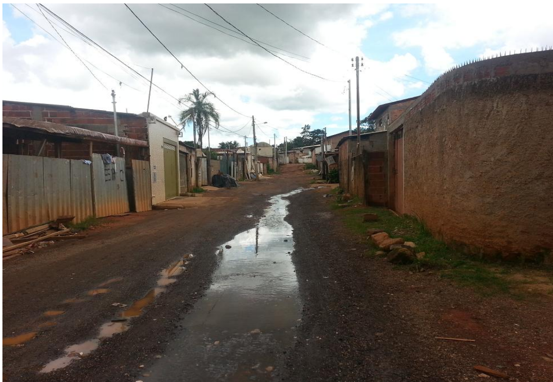
Foto 1 – Esgotamento Sanitário na Vila Cauhy – Realizada em 05/10/2014.
